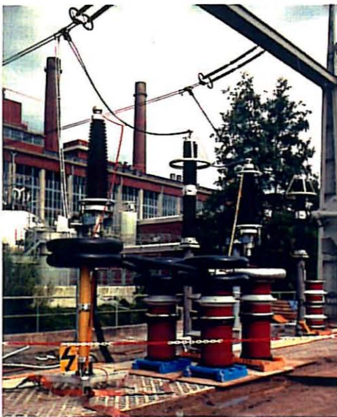
Figur 9: Vor-Ort-Wechselspannungsprüfung einer 220-kV Kabelanlage mit VPE-Isolation.
