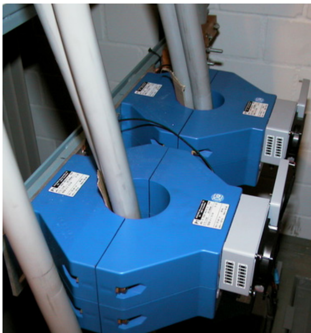
Abbildung 6 Montage der Spezialstromwandler auf der Unterspannungsseite (links) und der Oberspannungsseite (rechts)
