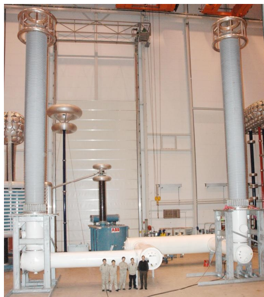
Bild 12 Versuchsaufbau für das Schalten von Steuerkondensatoren im Leistungsschalter durch einen Trenner entsprechend IEC 62271-102 im Hochspannungslabor STRI
