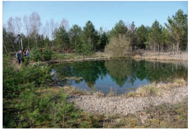
Abb. 15: Künstliche Löschwasserversorgung – offener Kunstteich mit solarbetriebener Pumpe zum ständigen Füllen, Ufer- und Überlaufzonen im Waldgebiet um Halbe
