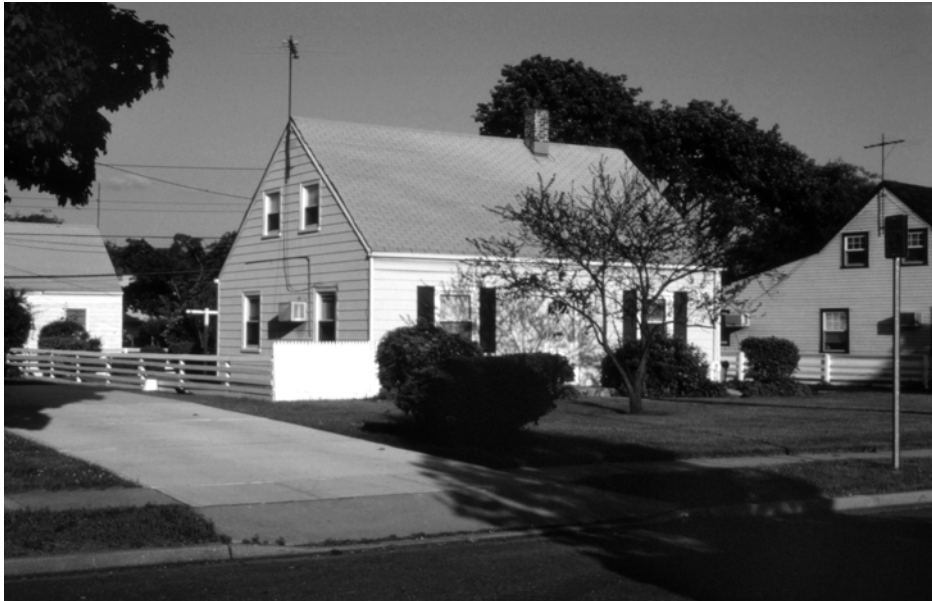
Abb. 4: Um das Jahr 2000 waren noch knapp 200 Häuser wie dieses weitgehend im Originalzustand erhalten; heute soll es nur noch eine Handvoll sein (Foto: Rüdiger Krisch).
