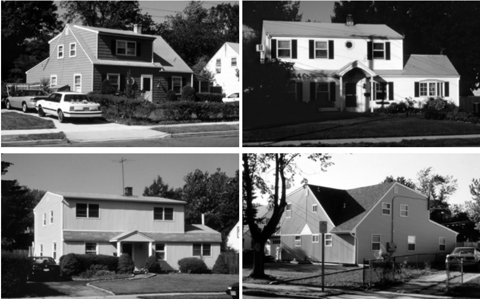
Abb. 5a-d: Renovierte Häuser; das einfache konstruktive Grundsystem der Häuser ermöglicht Erweiterungen und Veränderungen, hinter denen die Grundsubstanz kaum oder auch gar nicht mehr erkennbar ist (Fotos: Rüdiger Krisch).
