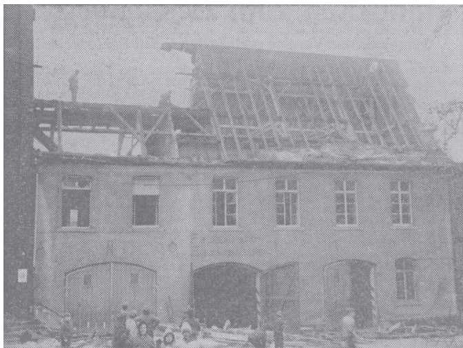
Abriss des Aula-Flügels bei der Annakirche, unten früher die Feuerwehr Foto: Kleppel
