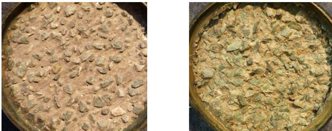
Abbildung 62: Exemplarische Darstellung der Oberflächenstruktur eines untersuchten Bohrkerns vor (links) und nach der Frost-Tauwechsel-Beanspruchung (rechts)
