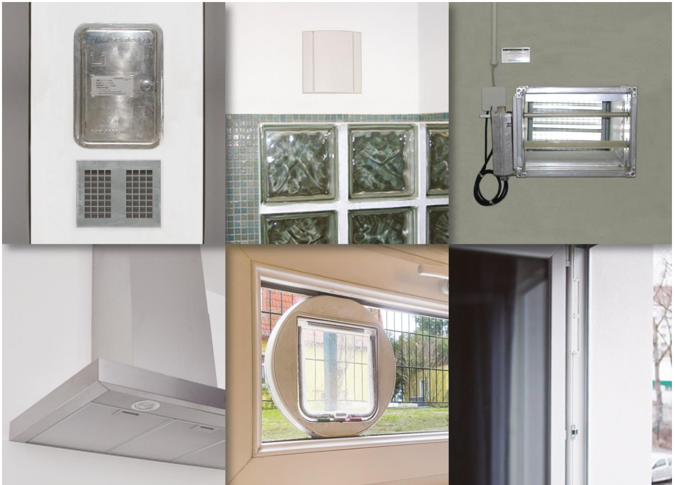
Abb. 3: Abdichten - nein danke: Kaminhinterlüftung, Abluftöffnung im fensterlosen Bad, Fahrerschachtbelüftung, Ablufthaube, Katzenklappe und ein der freien Lüftung dienender Fensterfalzlüfter (von oben links nach unten rechts) sind Beispiele von Öffnungen, die man für GEG-Schlussmessungen nicht abdichten darf. © Collage und Fotos: FLiB
