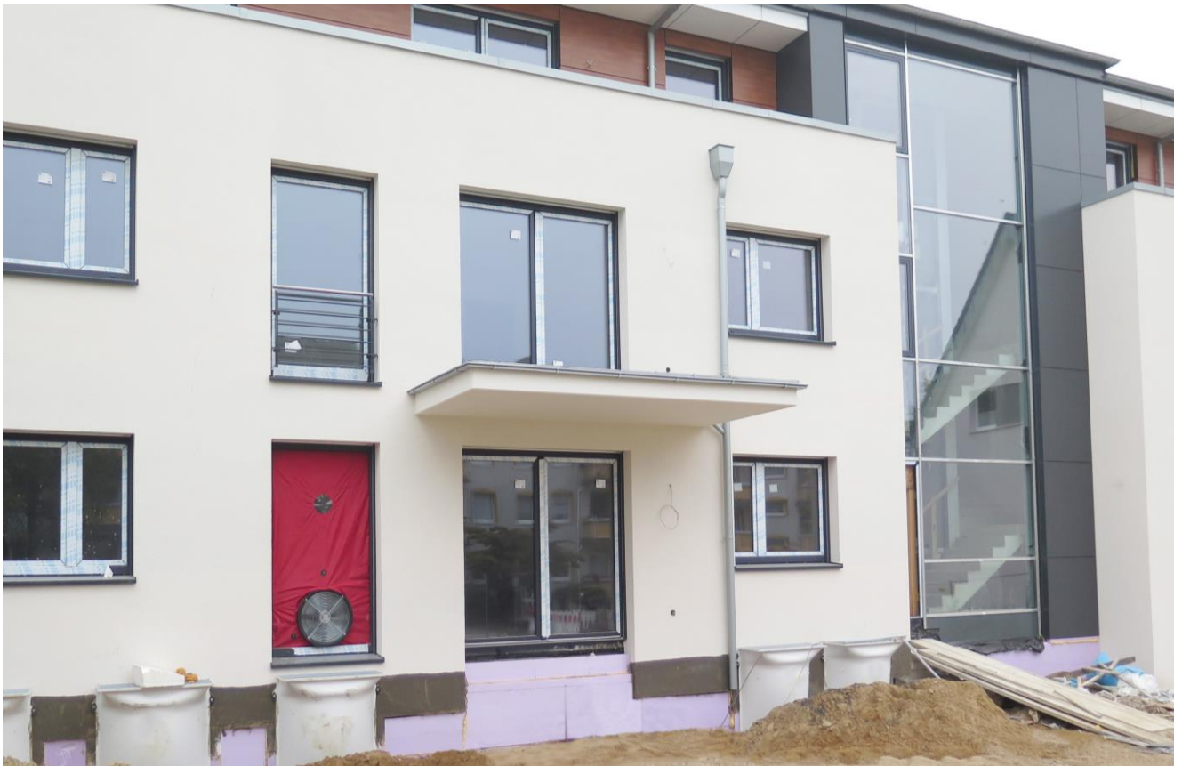
Abb. 3: Eckdaten für Blower-Door-Test gesucht: Bevor es ans Messen gehen kann, brauchen Messteams zahlreiche Infos zum Objekt. Ein neuer Fragebogen des FLiB e. V. hilft bei deren Abfrage. Zu finden unter www.flib.de . © Foto: FLiB
