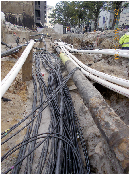
Abb. 2: NRM, Frankfurt, Große Gallus, spartenübergreifende Medienverlegung (2015)
