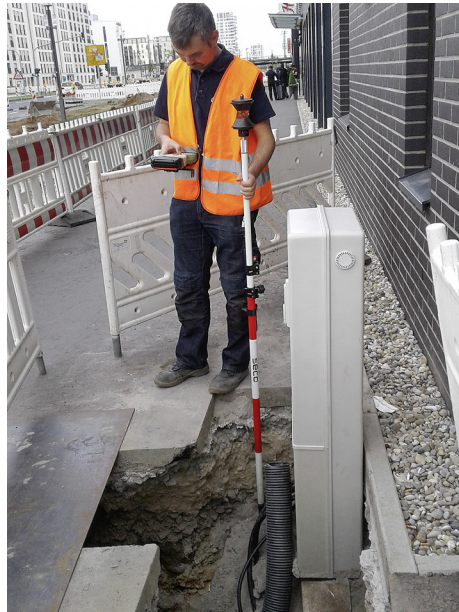
Abb. 5: NRM, Frankfurt, Europaallee, Sparte Strom, Leitungsaufmaß mit Totalstation und Plastikspitze (2017)
