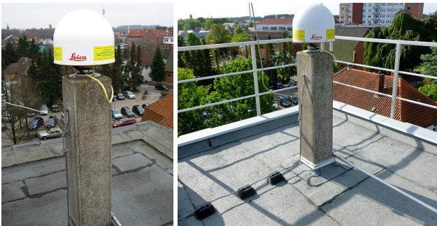
Abb. 6: SAPOS-Station Cloppeburg mit und ohne Absturz- sicherung
