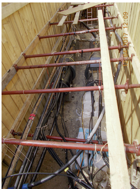
Abb. 1: NRM, Einführung Ffm Umspannwerk Kleyerstraße im Bau (2016/2017)
