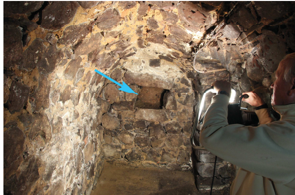
Abb. 17: Blindfenster im Keller Schloßstraße 1 (Pfeil) mit Tuffanschnitt (Foto: O. Tietz)
