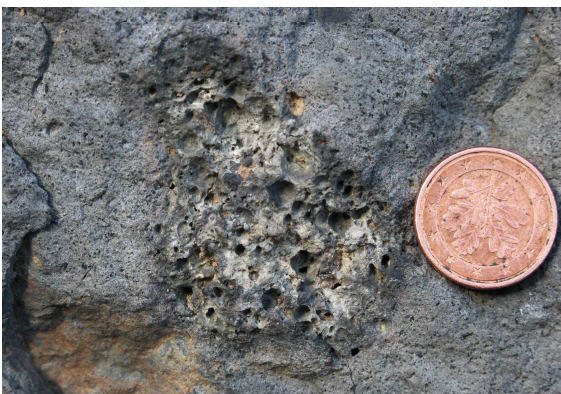
Abb. 16: Einschlüsse von Basaltschlacken im Basalt von Stolpen, Bruchsteinmauern im 1. Burghof: Ostfassade Kornhaus/Hauptwache (oben) und nördliche Burgmauer/Klengelsburg (unten) (Foto: O. Tietz)
