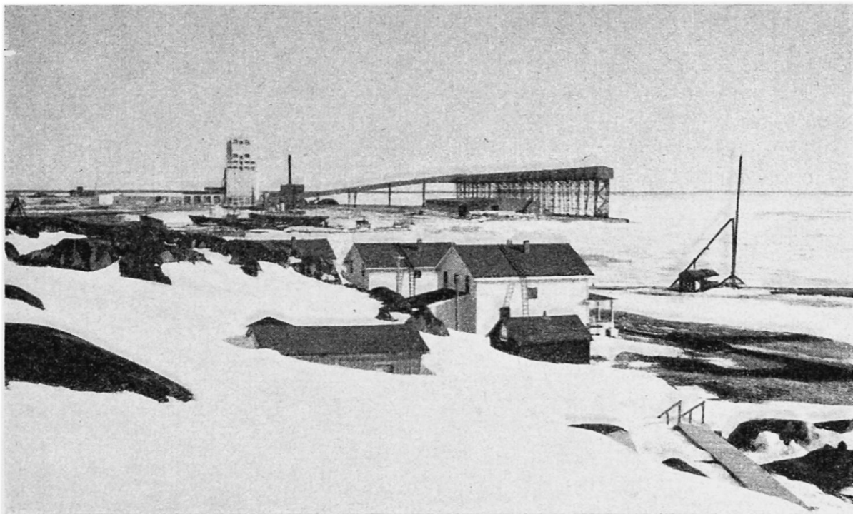
Blick auf den Hafen von Churchill, in Richtung SE. Links der Silo, rechts davon Mole und Anlagen für die Getreideverladung (Fließbänder und Röhren). Im Vordergrund Notspital, nur im Sommer geöffnet. Photo A. HUBER, 1. Mai 1951
