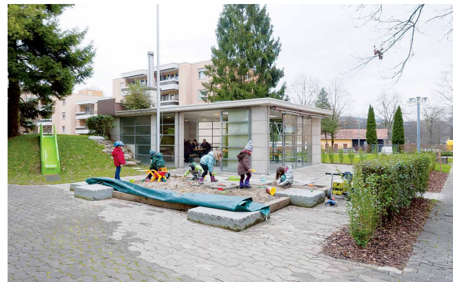
Spielplatz nach der Sanierung
