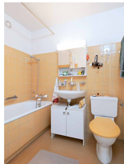
Bad vor der Sanierung Euelstrasse 25
