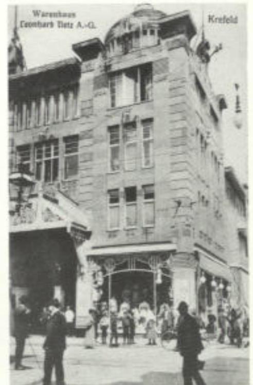
Abb. 4. Das ehemalige Kaufhaus Tietz — später Kaufhof; Ecke Friedrichstraße / St.-Anton-Straße
