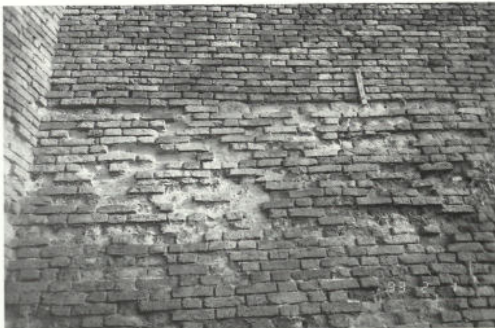
Abb. 11. Mauerverband im Schnittpunkt der Bauabschnitte 1, 2 und 8 (vgl. Abb. 7)
