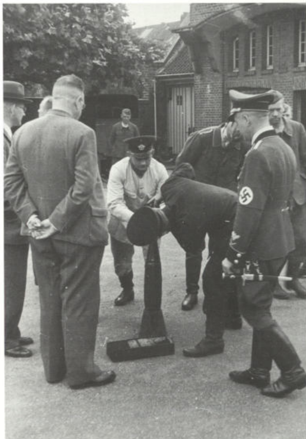
Abb. 7. Demonstrationsübungen mit Brandbomben waren nicht unüblich; hier eine Aufnahme vom 14. August 1941, die das Abbrennen englischer Mehrfachbomben auf dem Platz der Feuerwache Florastraße zeigt
