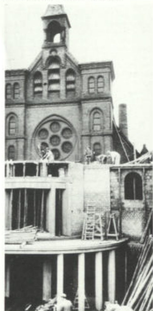
Abb. 7. Bau des neuen Turmes 1957
