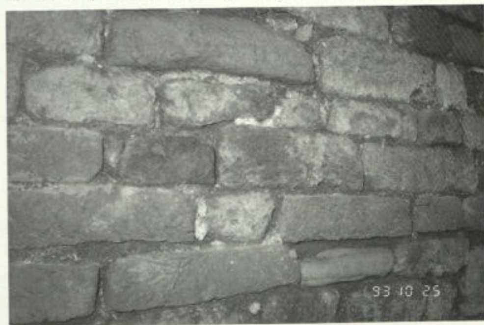
Abb. 12. Aus Tuff, Rollsteinen und Backsteinen hergestellter Mauerverband im Bauabschnitt 1
