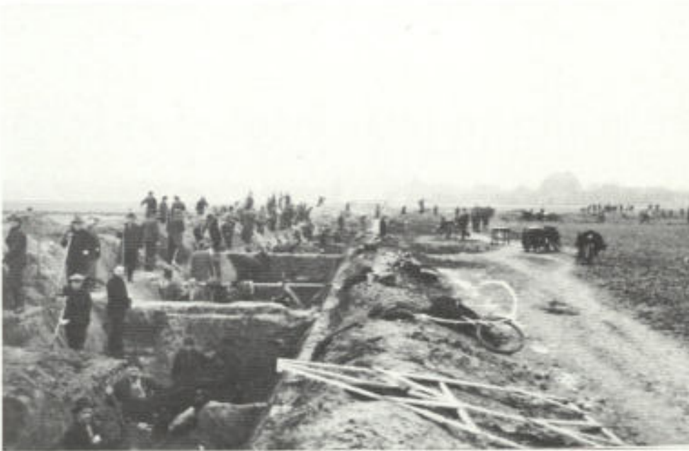
Abb. 11. Oktober/November 1944, Streckenabschnitt Fischeln — Anrather Straße; das hohe Gebäude ist das ehemalige Lungenkrankenhaus, Endpunkt des Grabens
