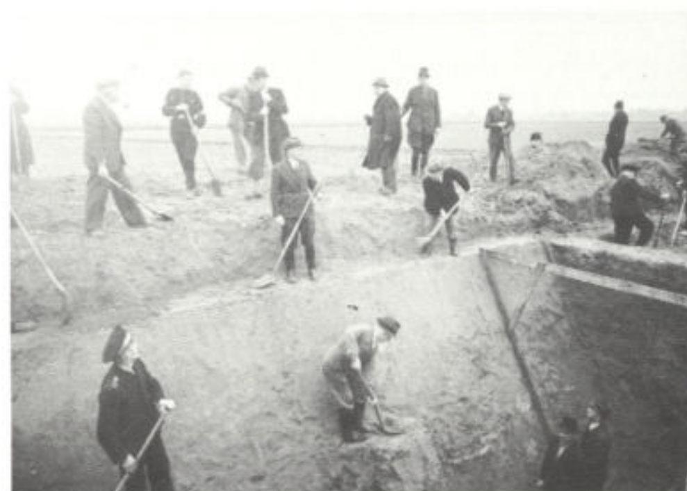
Abb. 7. Bald ist der Streckenabschnitt fertig.
