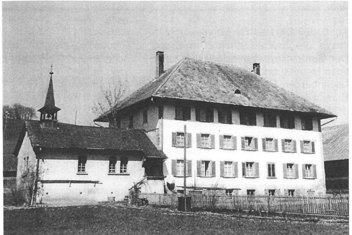
Die Armen- und Waisenanstalt Mörisegg mit Kapelle kurz vor dem Abbruch 1999
