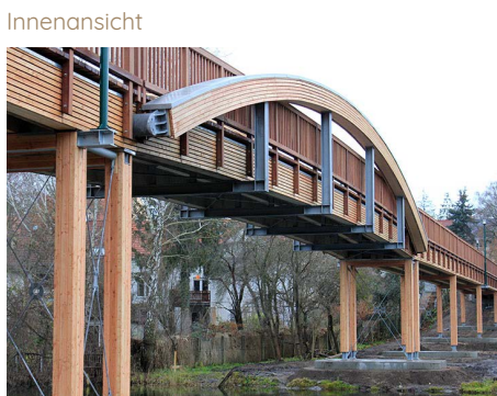
Ansicht mittleres Brückensegment
