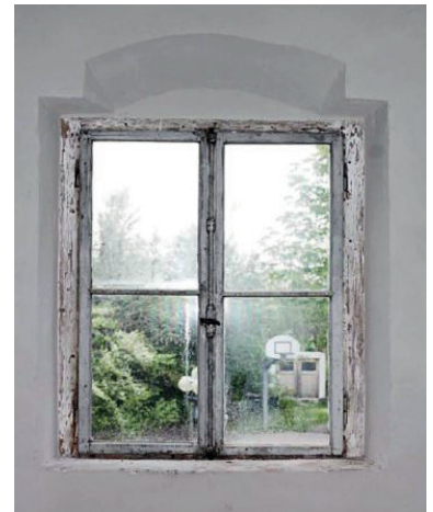
Alte Schäflerei, Kloster Benediktbeuern, OG, Nordseite, Fenster 1.26: Außen- und Innenansicht des Bestandsfensters im Vorzustand, Stockaußenmaß 1,14 \text{ m} \times 1,40 \text{ m} ( 1,60 \text{ m}^2 ), Quelle: Bichlmair et al., 2019b, S. 35
