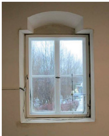
Alte Schäflerei, Kloster Benediktbeuern, OG, Nordseite, Fenster 1.27: Innenansicht des Fensters mit Erweiterung zum Kastenfenster, links mit geschlossenem Fenster, rechts mit geöffnetem Fenster, Quelle: Bichlmair et al., 2019b, S. 35
