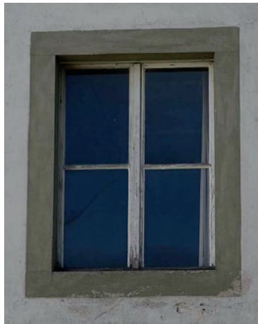
Alte Schäflerei, Kloster Benediktbeuern, OG, Nordseite, Fenster 1.26: Außen- und Innenansicht des Bestandsfensters im Vorzustand, Stockaußenmaß 1,14 \text{ m} \times 1,40 \text{ m} ( 1,60 \text{ m}^2 ), Quelle: Bichlmair et al., 2019b, S. 35
