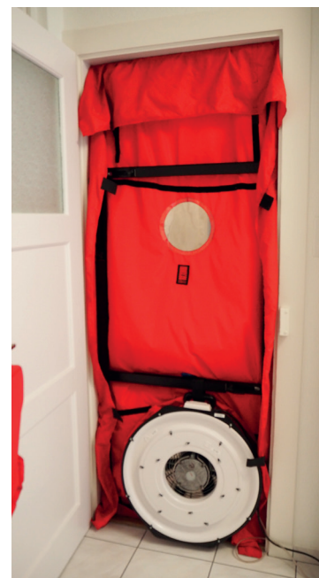
Für die a-Wert-Messung installierter Ventilator, Messung mit dem a-Wert Mess-System (BlowerDoor GmbH) Quelle: Wehle, 2018, S. 22
