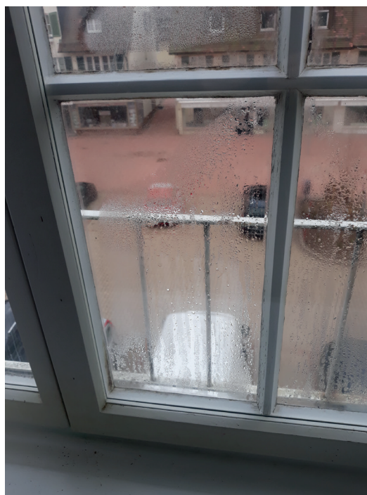
Der Einbau einer Isolierverglasung im inneren Flügel zur energetischen Verbesserung eines Verbundfensters kann bei bestimmten Wetterlagen zu Kondensatausfall an der kalten äußeren Scheibe führen. Die Folge sind Durchfeuchtung mit Schimmelbildung und optische Beeinträchtigung. Quelle: HolzmanufakturRottweil GmbH
