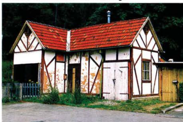
Das ehemalige Toilettenhäuschen ist in derselben Fachwerkbauweise wie der benachbarte Güterschuppen errichtet. Es steht am östlichen Ende des Bahnsteigs.
