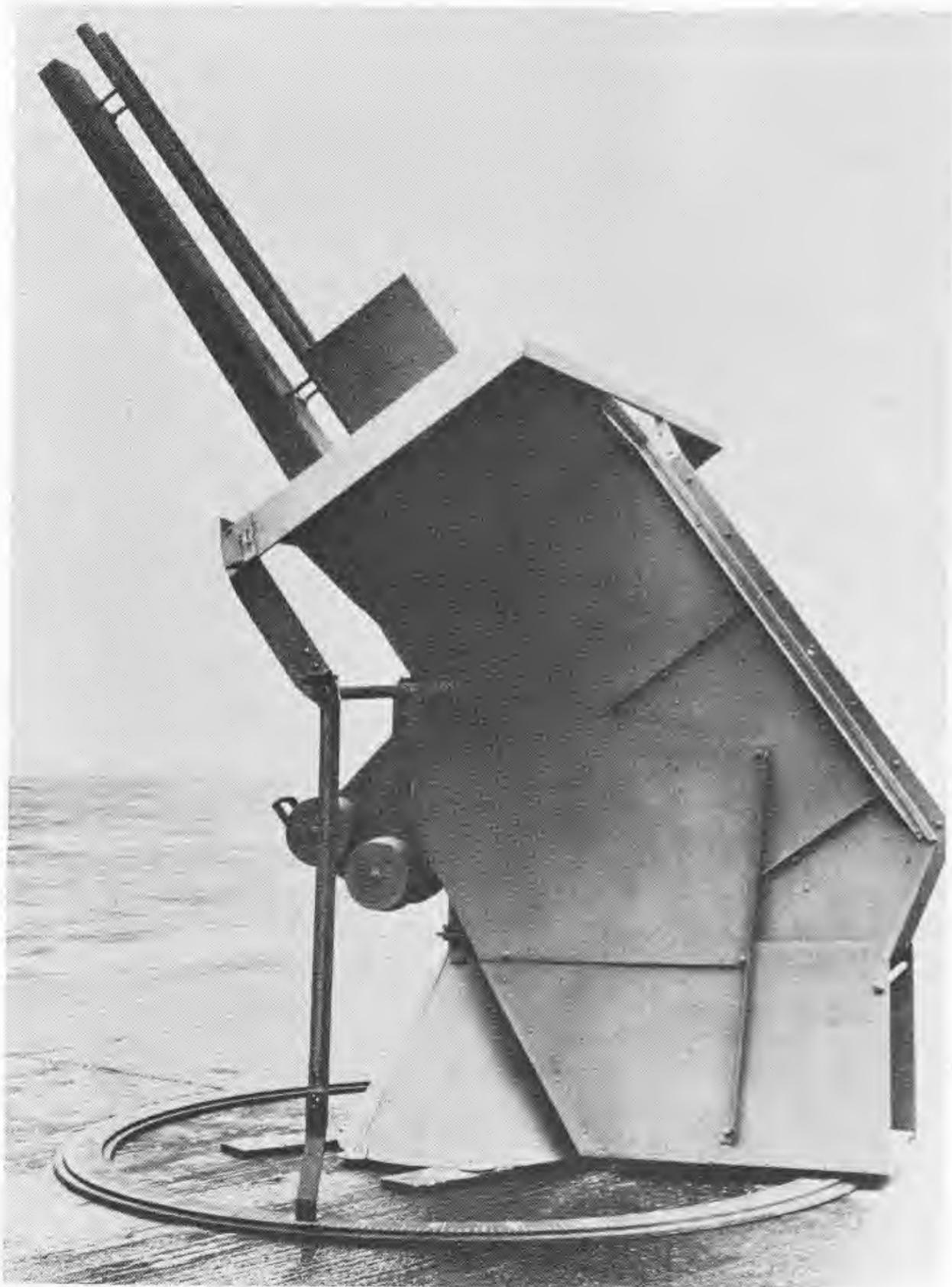
Bild 4: 3-Zoll-Projektor No. 1. Die einfache Blechverkleidung ist gut zu sehen
