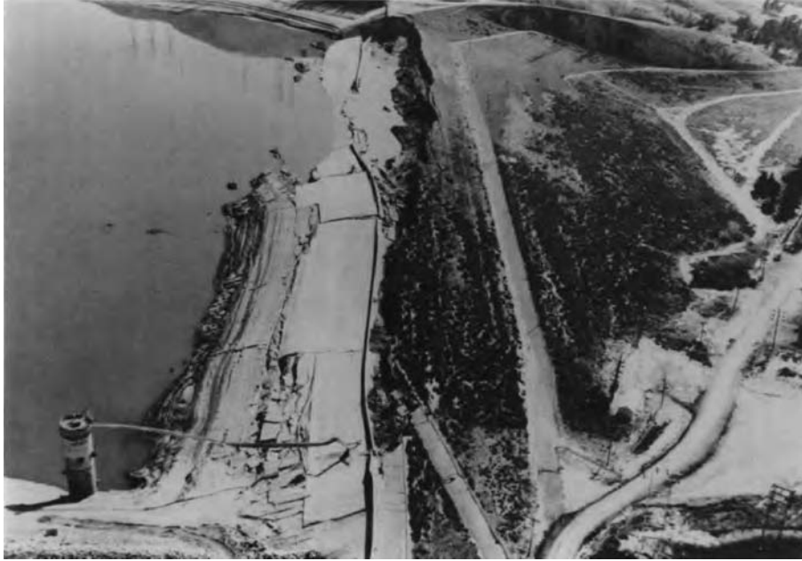
Abb. 3.2: Lower van Norman Dam nach dem Erdbeben von 1971
