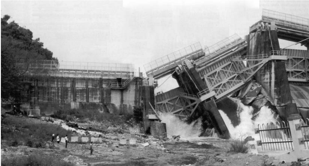
Abb. 3.1: Shih-Kang - Sperre nach dem Erdbeben von 1999, [3.26]
