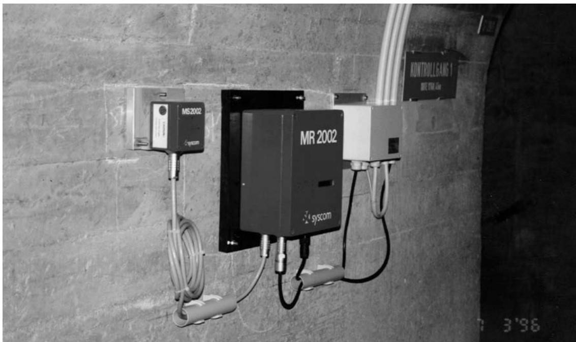
Abb. 2.1: Beschleunigungsaufnehmer in der Sperre Schlegeis
