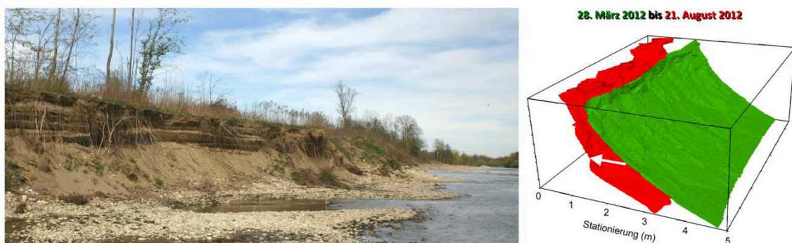
Abbildung 22: Materialeintrag durch Seitenerosion am Beispiel der Grenzmur (Habersack et al., 2013a).
