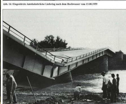
Abbildung 17: Sohldurchschlag (links) und Einsturz der Autobahnbrücke Lieferung (rechts) an der Salzach vom 13.08.1969 (WRS, 2000).
