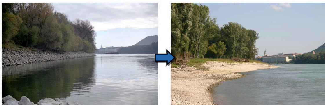
Abbildung 23: Uferrückbau im Bereich der Naturversuchsstrecke an der Donau (Fotos: via donau).
