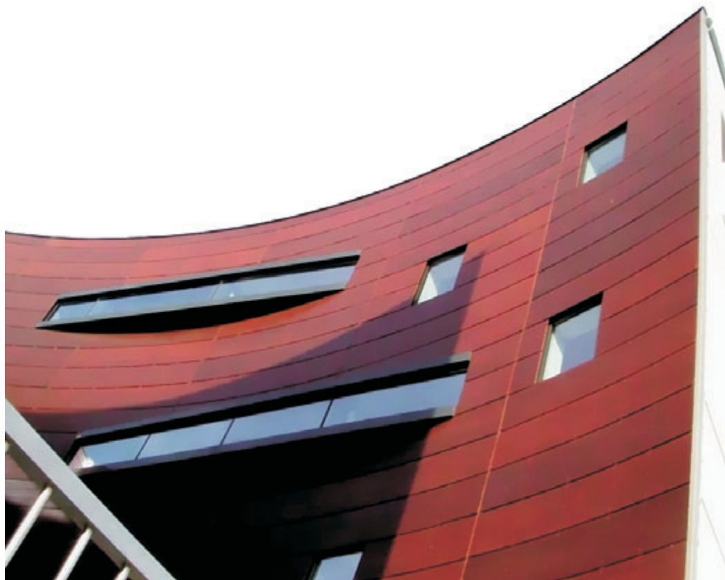
Abb. 3.3: Fassade aus Sperrholz
