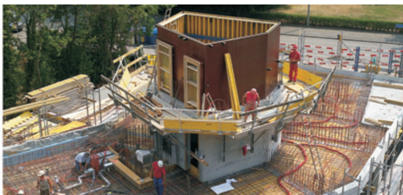
Abb. 3.2: Einsatz von Schalungsplatten aus Sperrholz im Hochbau
