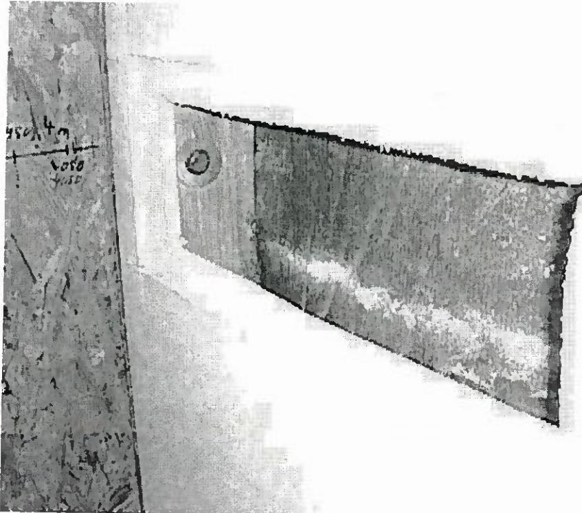
**Bild 16** Anschluss der Innenwand an die Außenwand mit Verschraubung 12 x 160 mm
