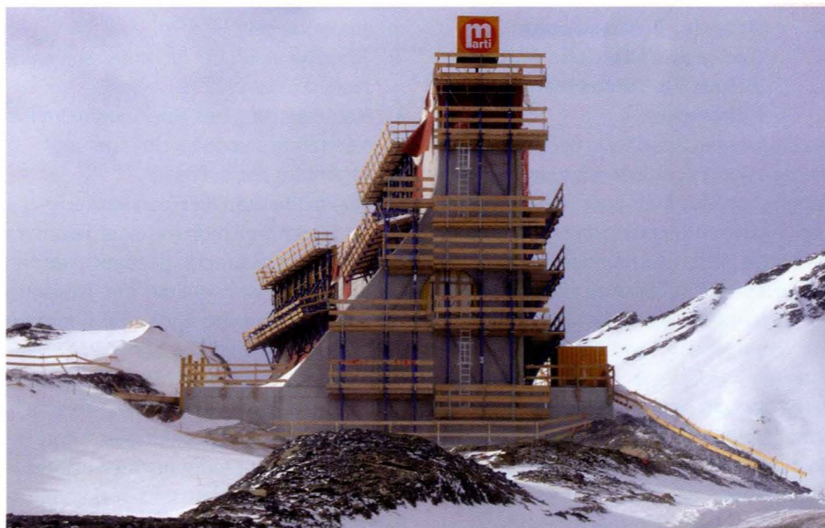
Bild 6. Vergrößerung des Muttsees um 15 Mio. m 3 durch eine neue, bis zu 35 m hohe Gewichtsmauer.
