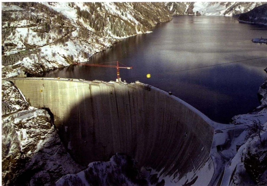
Bild 5. Bogenmauer Luzzone: Erhöhung um 17 m auf 225 m zwischen 1995 und 1999 mit Vergrößerung des Stauseevolumens um 20 Mio. m 3 , gleichbedeutend mit einer zusätzlichen Winterenergieproduktion von 60 GWh (Photo Maggia).
