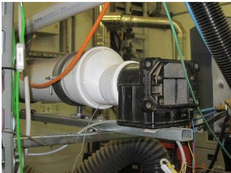
Abb. 1-1 Karman-Vortex-System, installiert in Ansaugleitung Verbrennungsluft des BHKW
