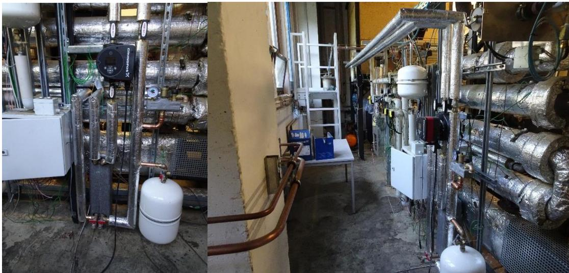
Abb. 1-72 links Anschlussstelle des Speicherkreislaufes mit Pumpe, MAG und WÜ; recht: gesamter Kreislauf mit Rohrstrecke zu den Speichern unter dem Tagesbehälter
