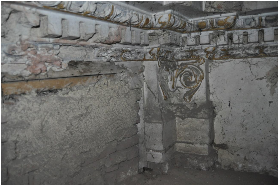
9.) Zbytky výzdoby původního divadelního sálu zachovalé na půdě dnešní knihovny, detail výzdoby.
