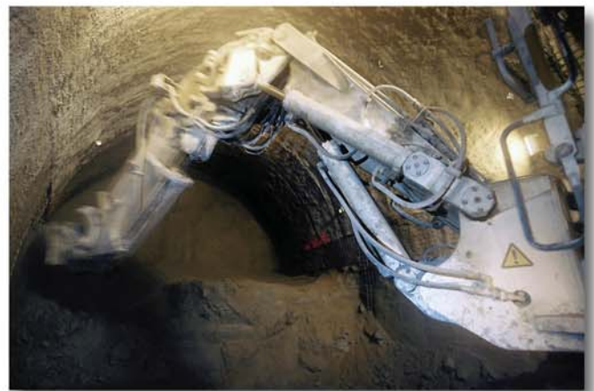
Aushub der voreilenden Kalotte
