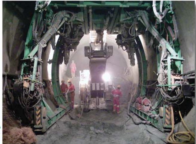
Tunnelvortriebsportal für Bohr- und Rammtätigkeiten
