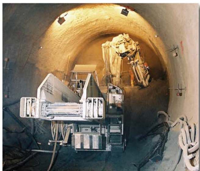
Aushub der Strosse
