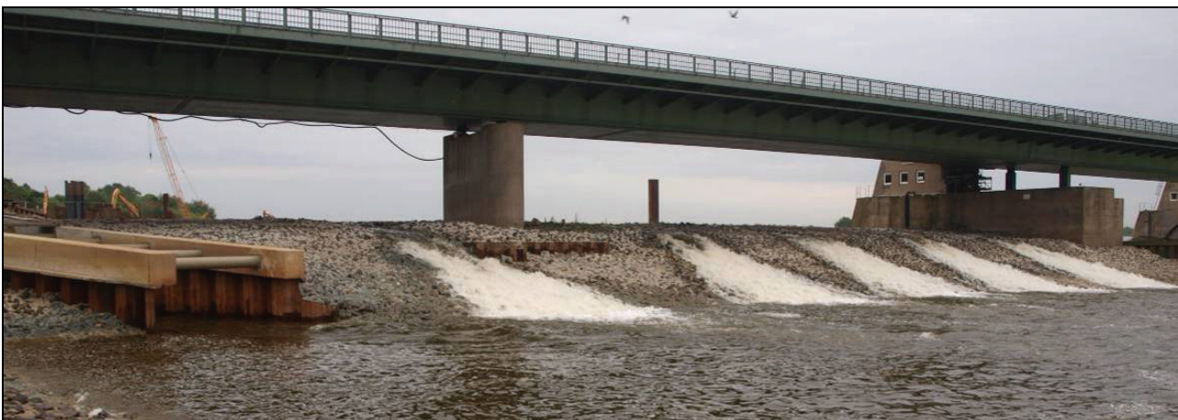
Bild 4: Sackgassenfreier Einstieg des Doppelschlitzpasses (links, Blick vom Unterwasser) mit den 5 benachbarten Zuwässerungsmulden in der benachbarten Wehrschwelle zur Unterstützung der Auffindbarkeit
