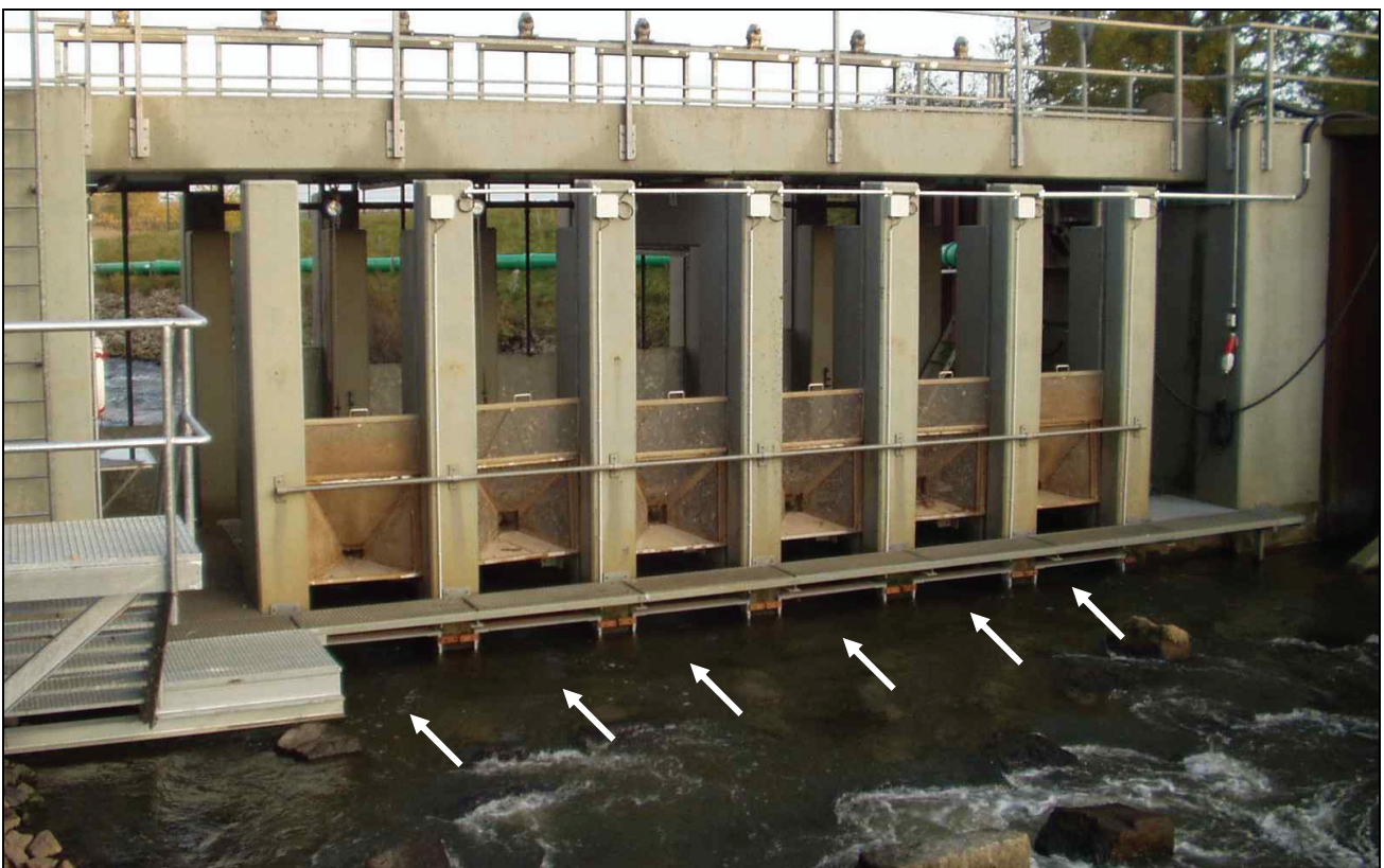
Bild 6: Im Umgehungsgerinne am Südufer sind 6 Rahmenantennen von jeweils 1 m x 1 m Größe in einer Reihe unter der ehemaligen Kontrollstation installiert
