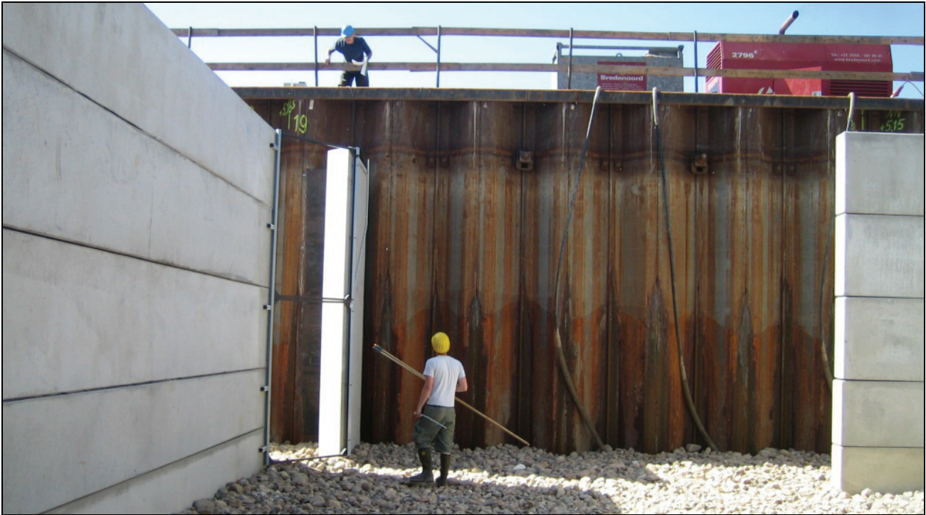
Bild 7:: Im Verlauf des Doppelschlitzpasses wurden insgesamt 18 Rahmenantennen von maximal 5,4 m Höhe und 1,3 m Breite in die Schlitze eingebaut.
