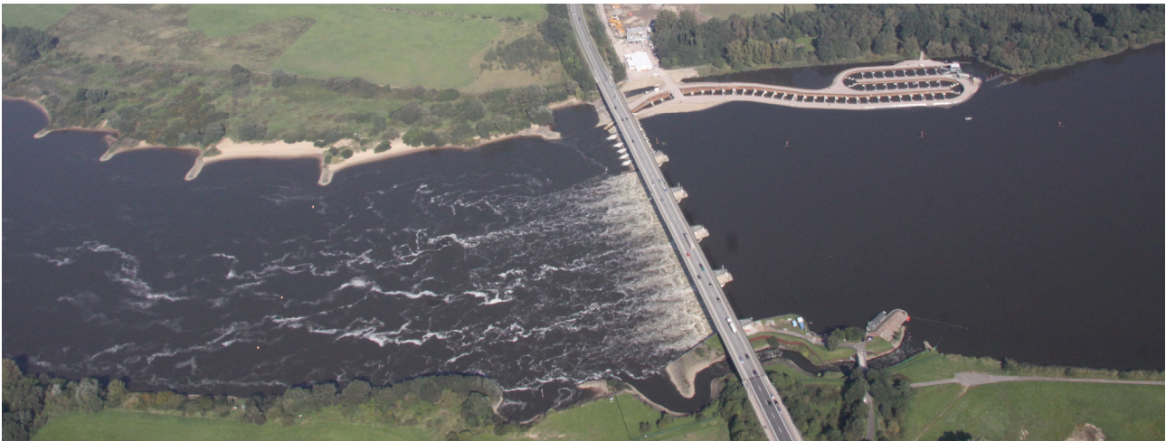
Bild 3: Die Staustufe Geesthacht mit dem prallhangseitigen Umgehungsgerinne (im Bild unten) und dem am Gleithang neu errichteten Doppelschlitzpass (Photo: Timo Jann)
