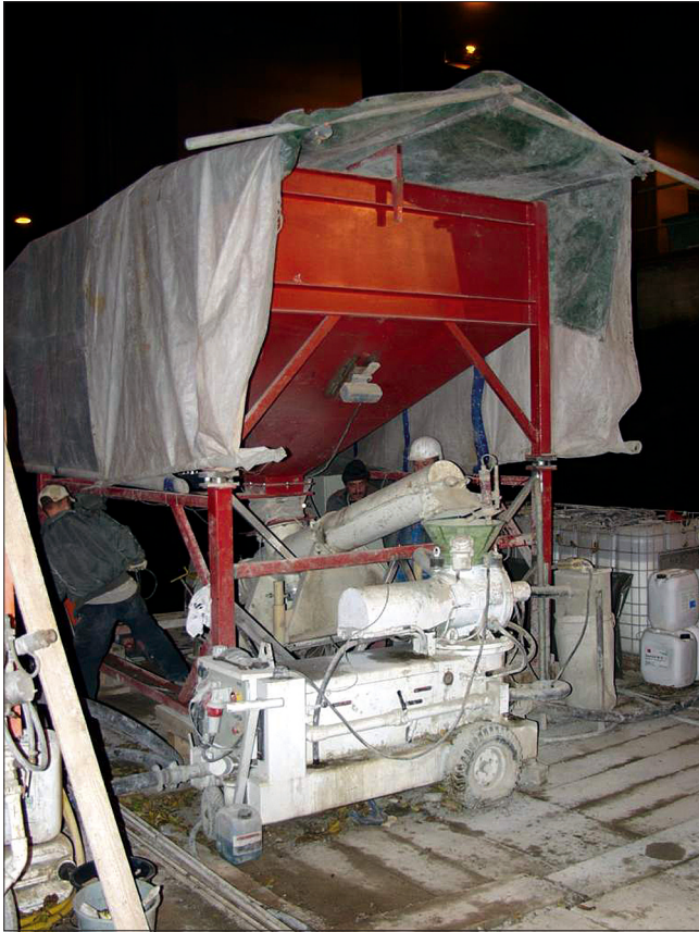
Bild 9: Spritzbetonanlage auf dem Arbeitsponton
