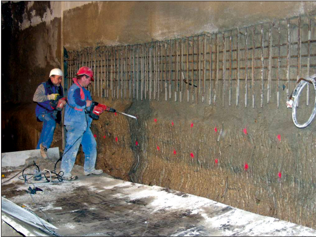
Bild 7: Ankereinbau
