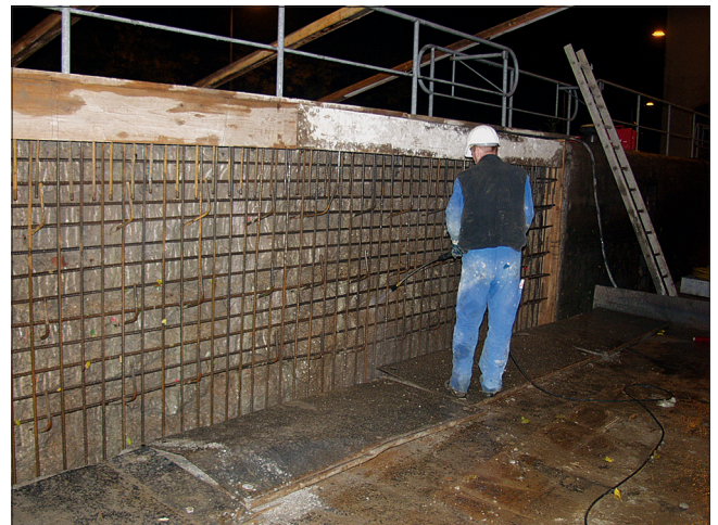
Bild 8: Bewehrungseinbau
