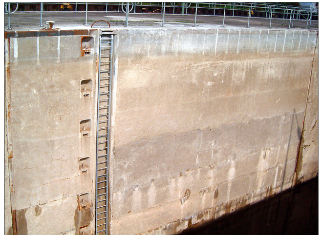
Bild 27: Ansicht nach Fertigstellung
