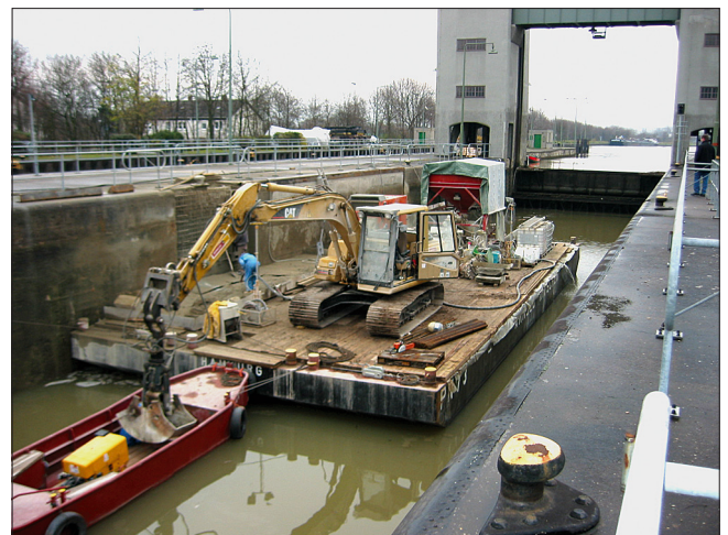
Bild 4: Arbeitsponton mit Geräten
