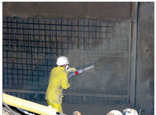
Bild 12: Spritzbetonauftrag 2. Lage
