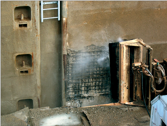
Bild 26: Abbruch der vierten Lamelle mittels HDW
