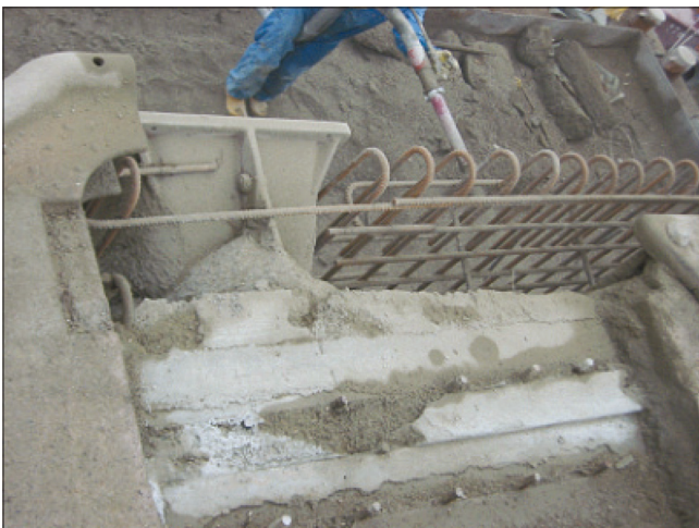
Bild 15: Einbau eines Nischenpollers
