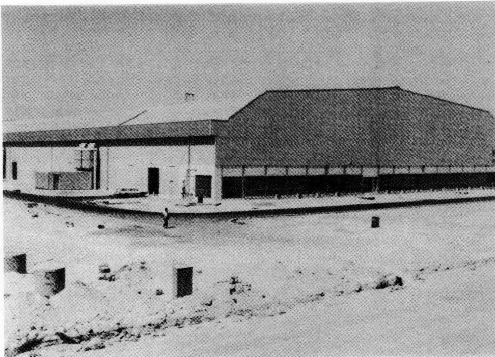
Bild 3 Ansicht der fertigen Modellhalle
