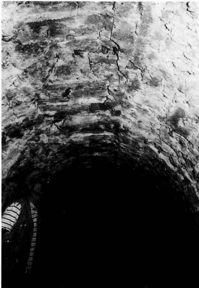
Bild 2: Schalbrettabrücke in der Wasserleitung nach Side/Türkei. Man erkennt die Abdrücke in Längsrichtung und am First einen etwa 50 cm breiten Bereich in Querrichtung
