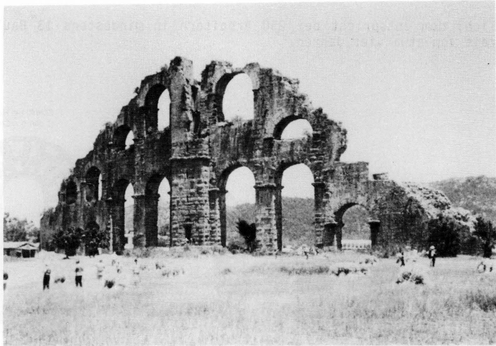
Bild 9: Aspendos/Türkei. Zum Abbau des schädlichen Druckes an zwei Knickpunkten der dortigen Druckwasserleitung wurden rund 30 m hohe "Wassertürme" errichtet, die oben offene Behälter trugen.
