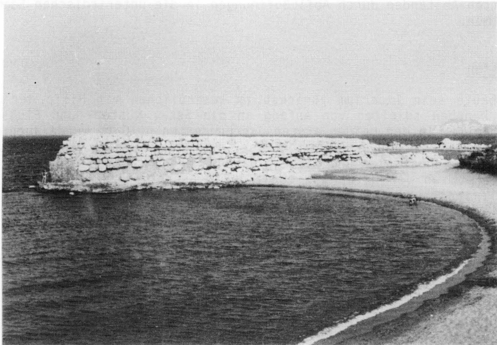
Bild 13: Mole für den antiken Hafen Ampurias/Spanien. Das heute 85 m lange Bauwerk besteht aus Römischen Beton mit Steinblöcken als Schale.
