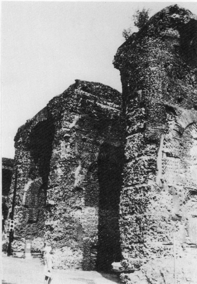
Bild 6: Aquädukt bei Lyon/Frankreich. Die Pfeiler bestehen aus Römischen Beton mit einer Schale aus Natursteinen und Ziegeln.
