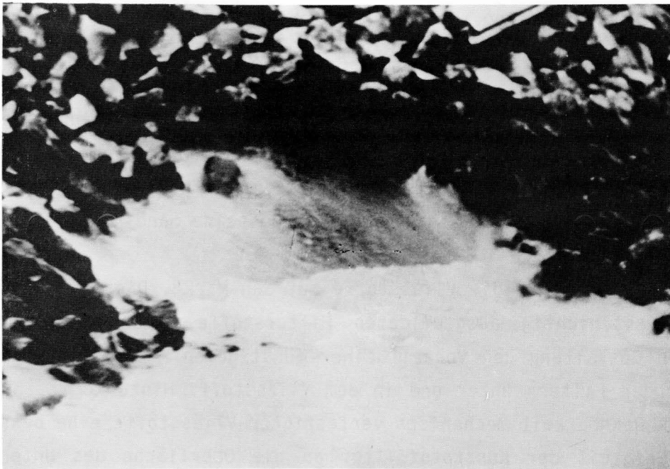
Abb. 7: Schäden in der Deckschicht
