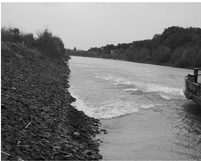
Bild 5.16 Abgrenzung zwischen unebrochenen Wellen, Wellen mit signifikanter Wiederauffüllungsströmung und vollständig gebrochenen Wellen bei der ufernahen Fahrt an Böschungen (Brecherkriterium)
