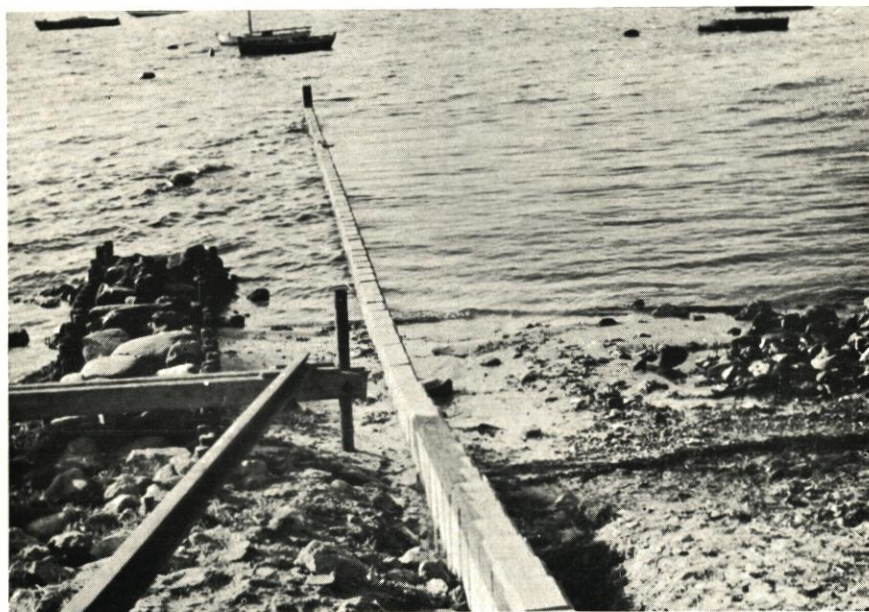
Abb. 34. Stahlbetonbühne bei Eckernförde, 12. Oktober 1951
