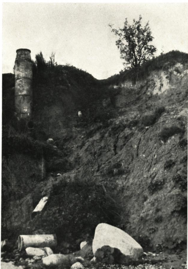
Abb. 37. Am Brodtener Ufer frei stehender Dränschacht, 29. September 1950
