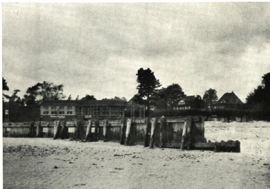
Abb. 38. Travemünde, 24. Oktober 1949, 14.15 Uhr. Bühne vor dem Strandpavillon. Landseitiger Teil aus Holzspundbohlen mit Fenstern bei — 1 m MW
