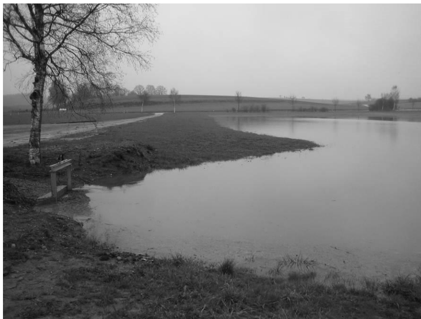
Abbildung 8: Blick von der gegenüberliegenden Talseite beim Teileinstau. Im Vordergrund ist das Drosselorgan zu erkennen [Foto: Herr Egle, IB Schranz, Bad Saulgau]
