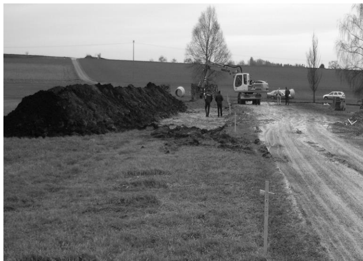
Abbildung 6: Beginn der Baumaßnahme mit Einbau der stauraumseitigen Dichtung
