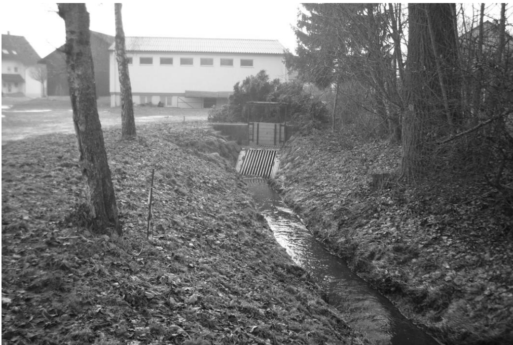
Abbildung 1: Einmündung des Nonnenbachs am Ortsrand von Moosheim in die Verdolung Im Einzugsgebiet des Nonnenbachs oberstrom von Moosheim bieten sich vornehmlich drei Bereiche zur Zwischenspeicherung an. In Abb. 2 sind die Lage dreier temporärer Speicherbecken und das jeweilige, grob abgeschätzte Speichervolumen bei Einstauhöhen um einen Meter angegeben.
