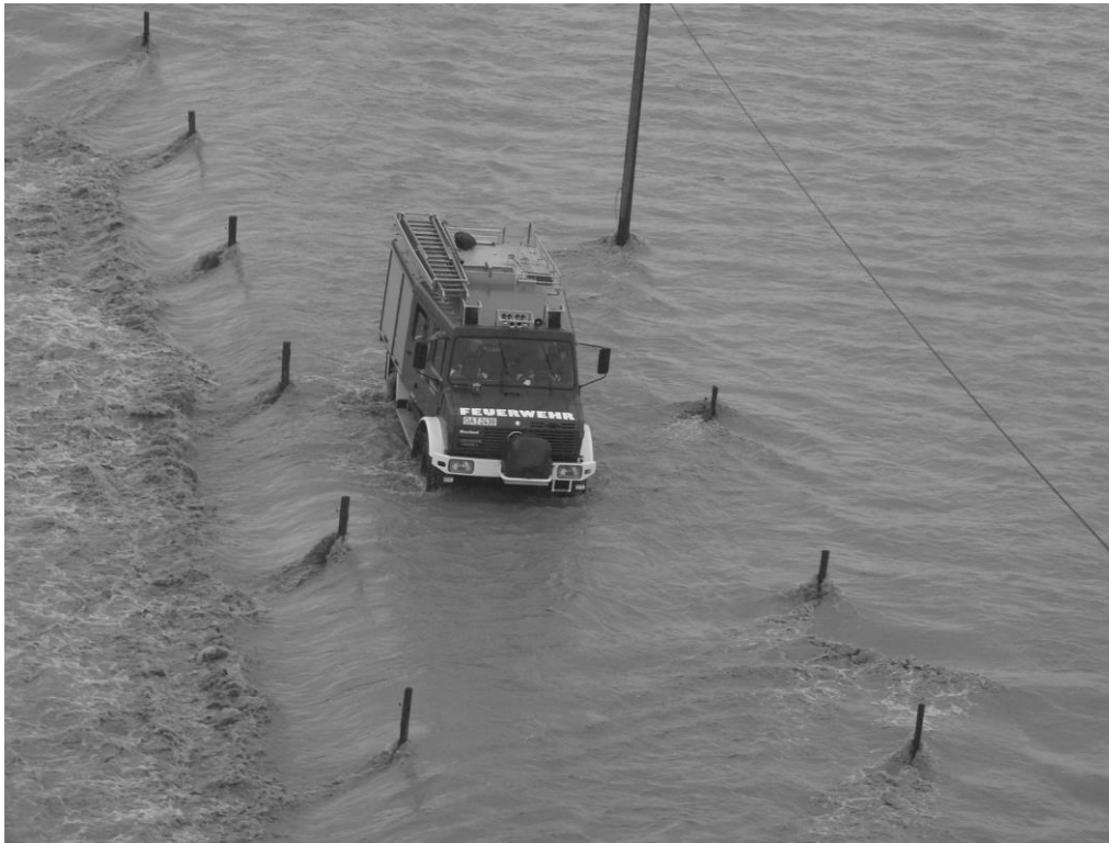
Abbildung 3: Überströmter Straßenkörper; deutlich erkennbar ist die Deckwalze am talseitigen Fuß des Straßendamms
