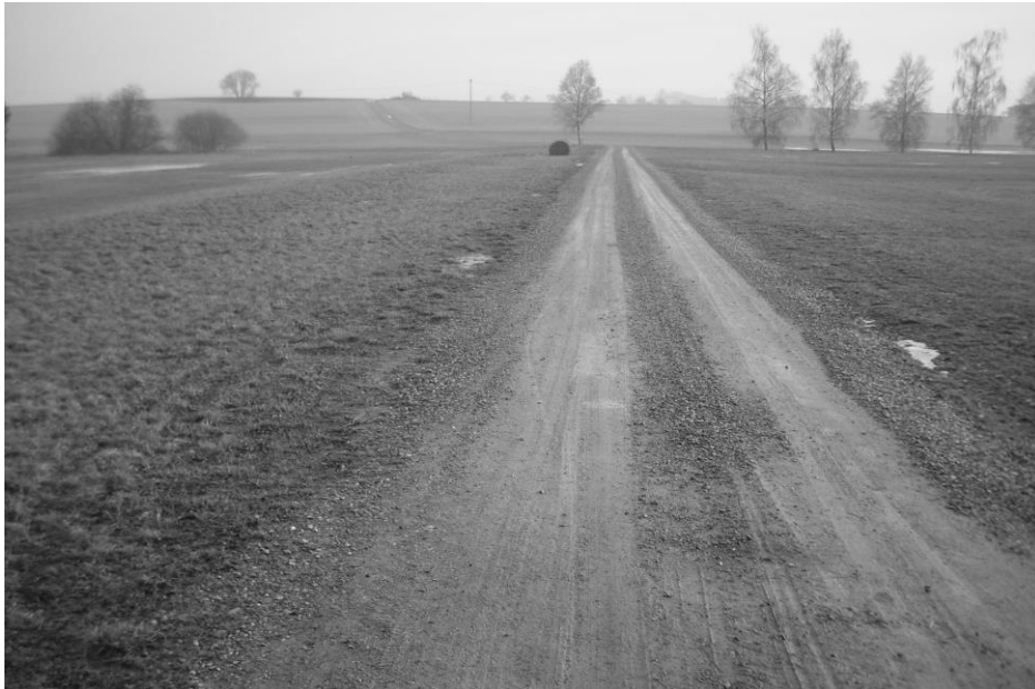
Abbildung 7: Wegedamm kurz vor Aufbau der Asphaltdecke. Die Seiten sind begrünt und landwirtschaftlich nutzbar.
