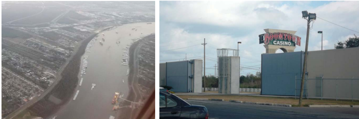
Abbildung 2: Hochwasserschutzdeiche beidseits des Mississippi oberhalb von New Orleans, LA, USA. Streichlängen ca. 1 km.
