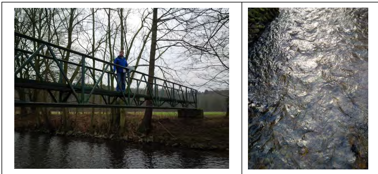
Abbildung 3: Links: Durchführung einer Radarmessung über das Messsteggeländer am Pegel Hummelsheim
