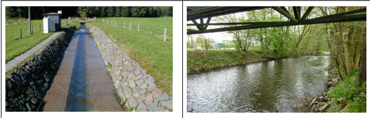
Abbildung 2: Messstellen unterschiedlicher Charakteristika (links Pegel Müllensiepen: ausgebautes Profil mit Niedrigwasserrinne, rechts Pegel Hummelsheim: begradigtes Gewässer, jedoch mit Geschiebetrieb)
