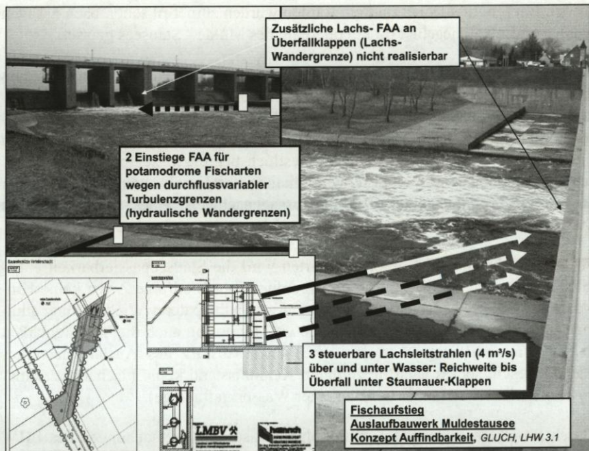
Abbildung 2: Konzept Auffindbarkeit Fischaufstieg Auslaufbauwerk Muldestausee
