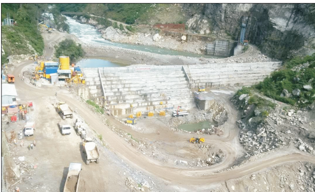
Abbildung 1: Heinrich, M.: "Dammabdichtungen im Königreich Bhutan - Spezialtiefbau in exponierten Verhältnissen", 5. Symposium: Sicherung von Dämmen, Deichen und Stauanlagen, Siegen, 2015.
