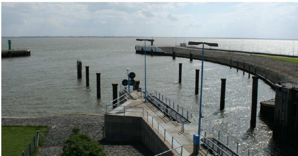
Abb. 2-24: Lage der GNSS-Station Buisum an der Schleuse Buisum
