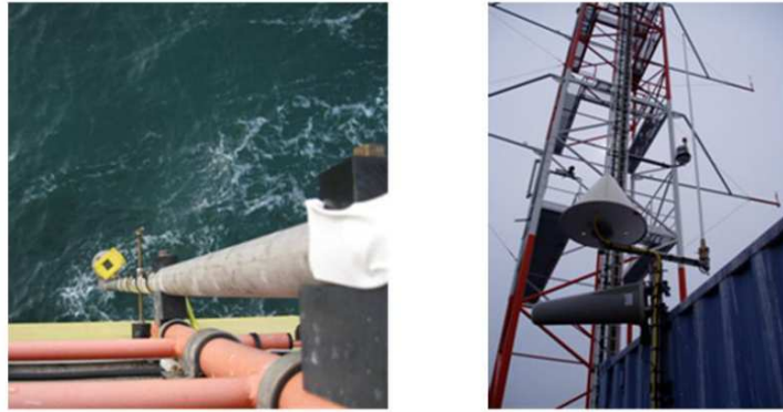
Abb. 2-28: Radarpegel (links) und GNSS-Station (rechts) auf der FINO-1
