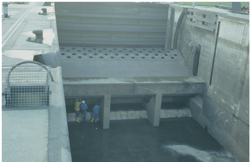
Bild 5 a und b: Drucksegmenttor der Saarschleuse Lisdorf
