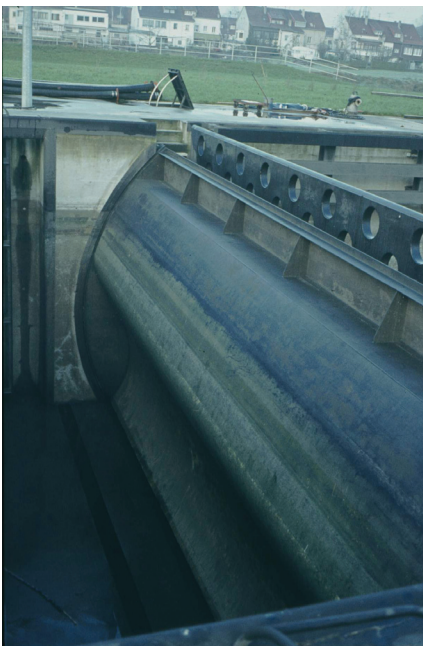
Bild 5 a und b: Drucksegmenttor der Saarschleuse Lisdorf
