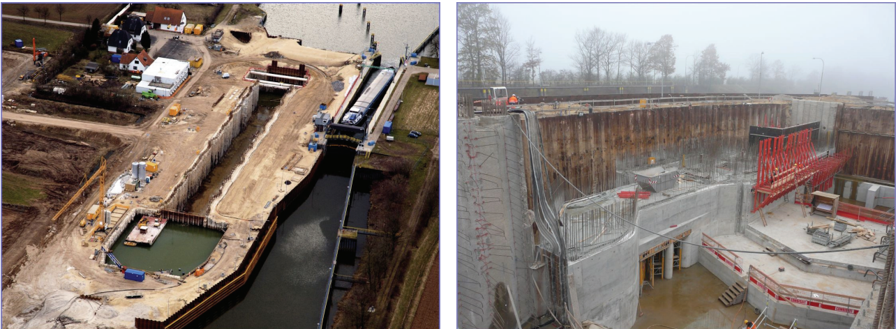
Bild 1 a und b: Unterhaupt Schleuse Dörverden, Baugrube und Bauzustand (Quelle: NBA Hann.)
