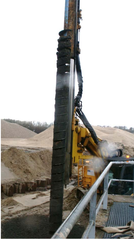
UVH Schleuse Uelzen
