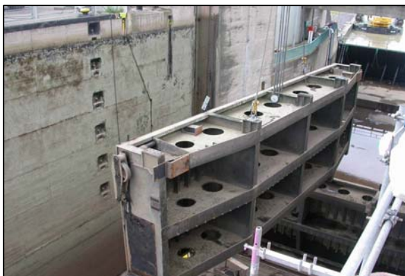
Bild 5: Demontage des Hubtorzwischenstücks
