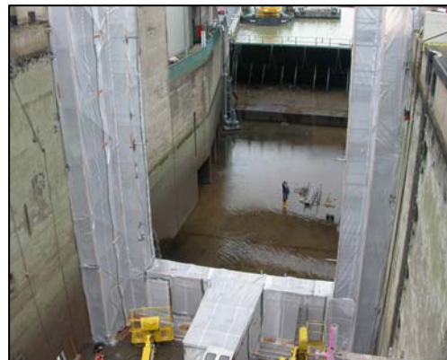
Bild 6: Einrüstung der Tormaske
