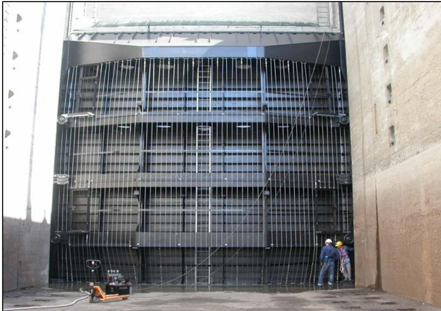
Bild 2: Neues Hubtor als Untertor an der Schleuse Hausen
