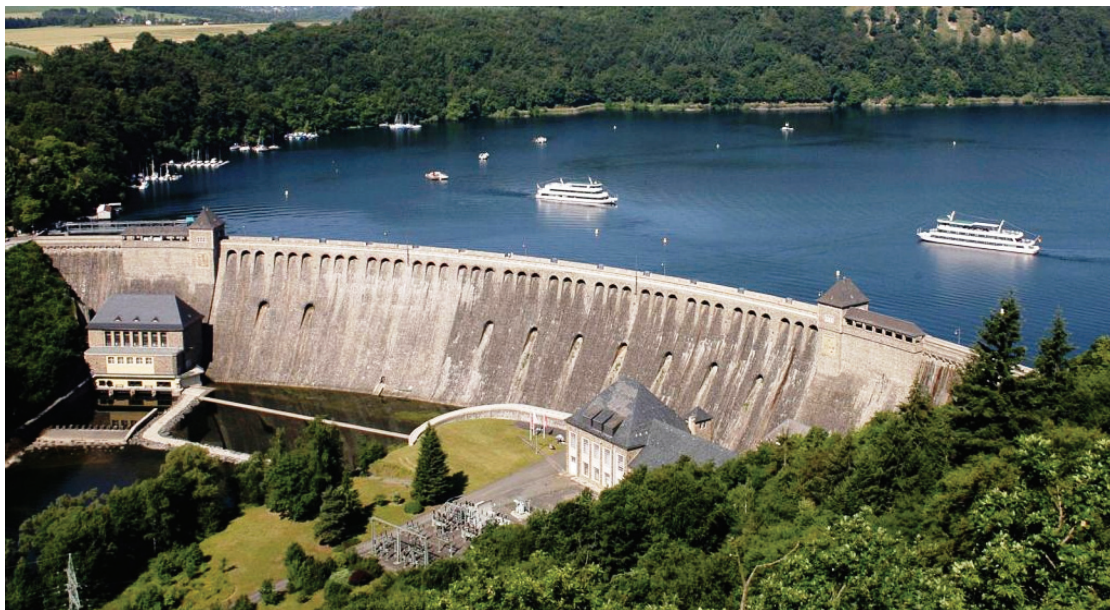
Bild 1: Luftbild der Edertalsperre
