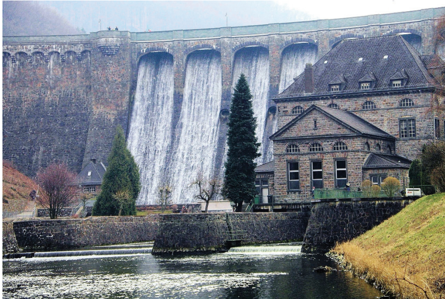
Bild 2: Blick von Unterwasser auf die Staumauer der Diemeltalsperre
