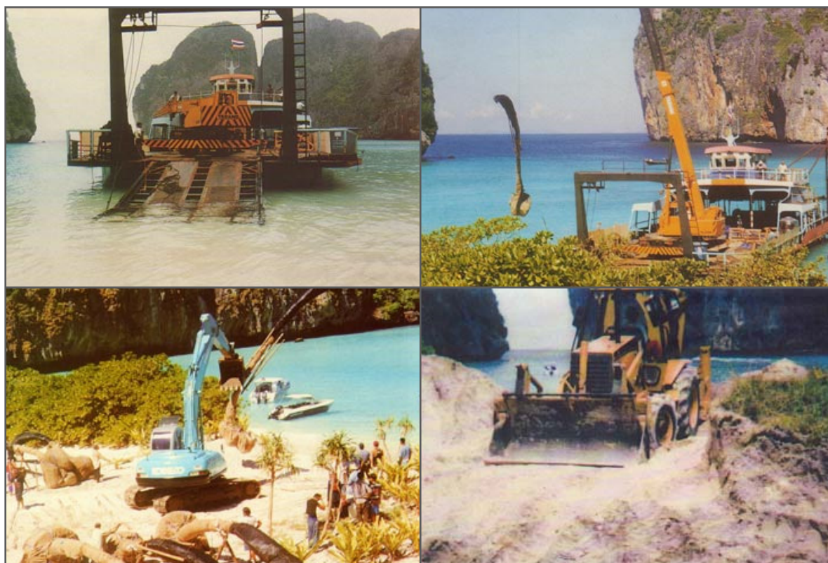
Abb. 72: Die Vorbereitungen für den The Beach -Dreh in der Maya Bay [Fotos: UNIVERSITY OF QUEENSLAND 2009]
