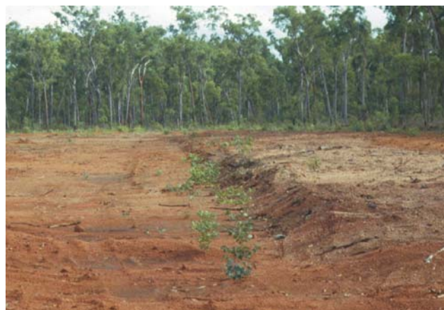
Abb. 3: Für den Bauxitabbau vorbereitete Fläche; ca. 60 cm Boden ist im Dual Strip -Verfahren (s.u.) abgetragen worden.
