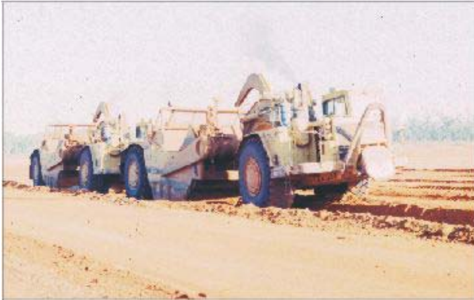
Abbildung 7: Abtragen des Bodens mit “openbowl-scraper” im Tandembetrieb.
