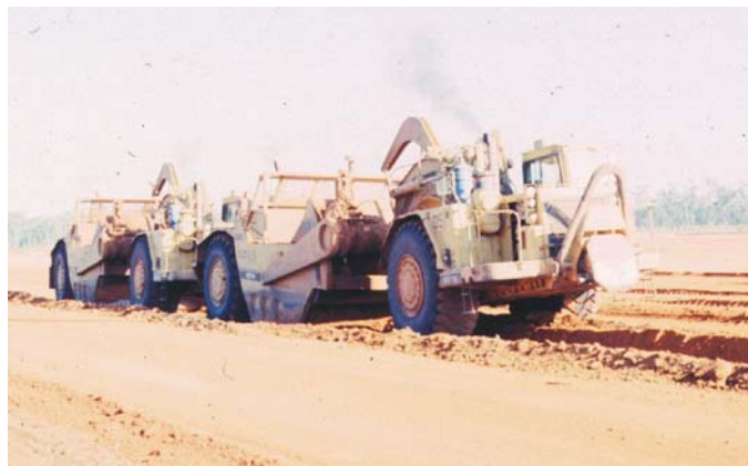
Abb. 2: Abtragen des Bodens mit Erdhobel (engl. scrapers) im Tandembetrieb.
