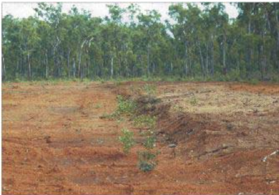
Abbildung 8: Frisch für den Bauxitabbau vorbereitete Fläche ist ca. 60 cm Boden abgetragen worden
