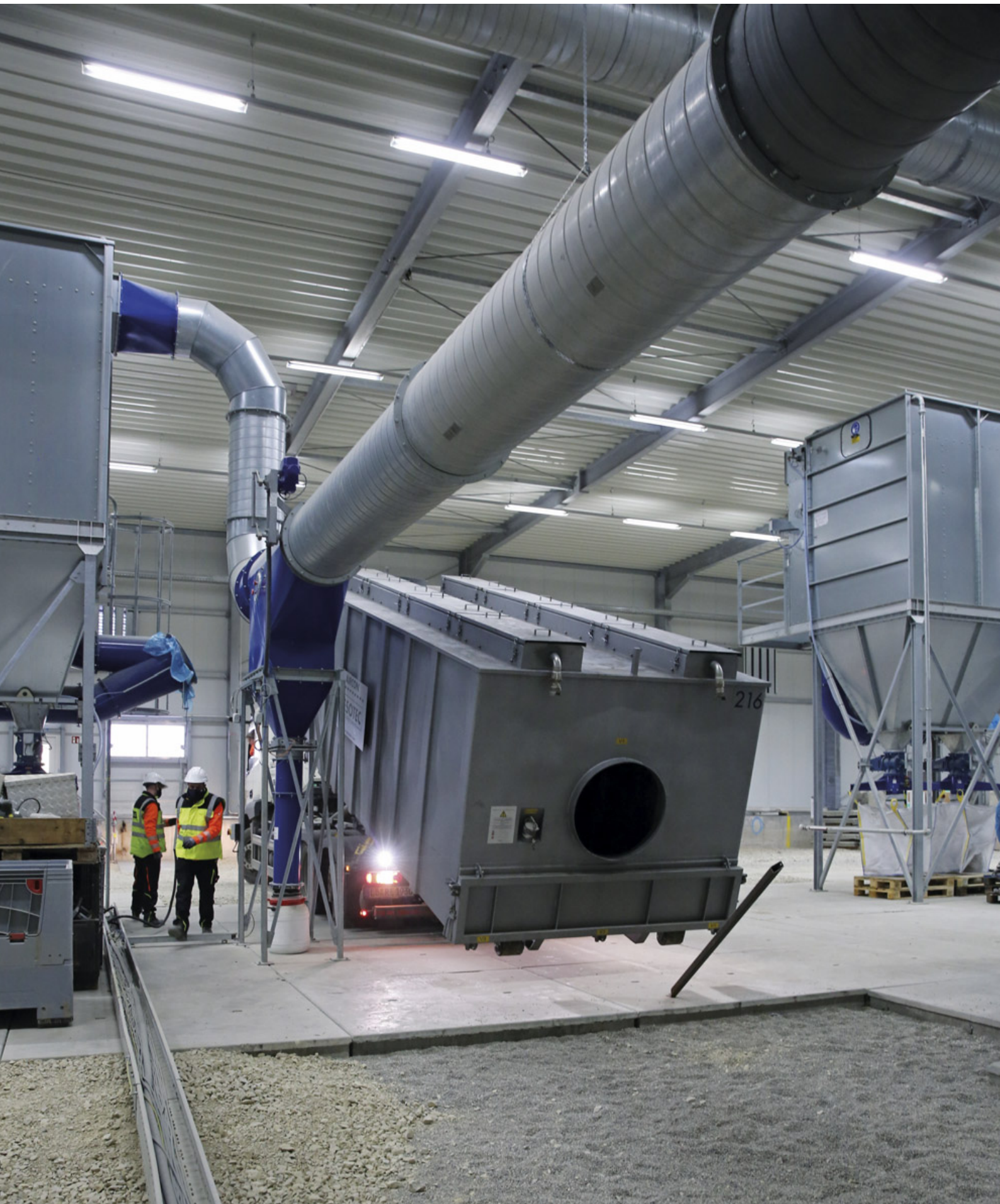
Abbildung 16: Austausch einer Aktivkohle-Filtereinheit der Abluftreinigungsanlage (Aufnahmedatum: 8. Dezember 2020)
