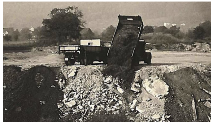
Abbildung 4: Die Gruben wurden ehemals mit Erde, Bauschutt und Hausmüll verfüllt (Quelle: unbekannt. Rechte: Da der Rechteinhaber nicht mehr ermittelt werden konnte, verpflichten wir uns, im Falle eines nachweislichen Anspruchs eine Lizenzgebühr in üblicher Höhe zu entrichten.)
