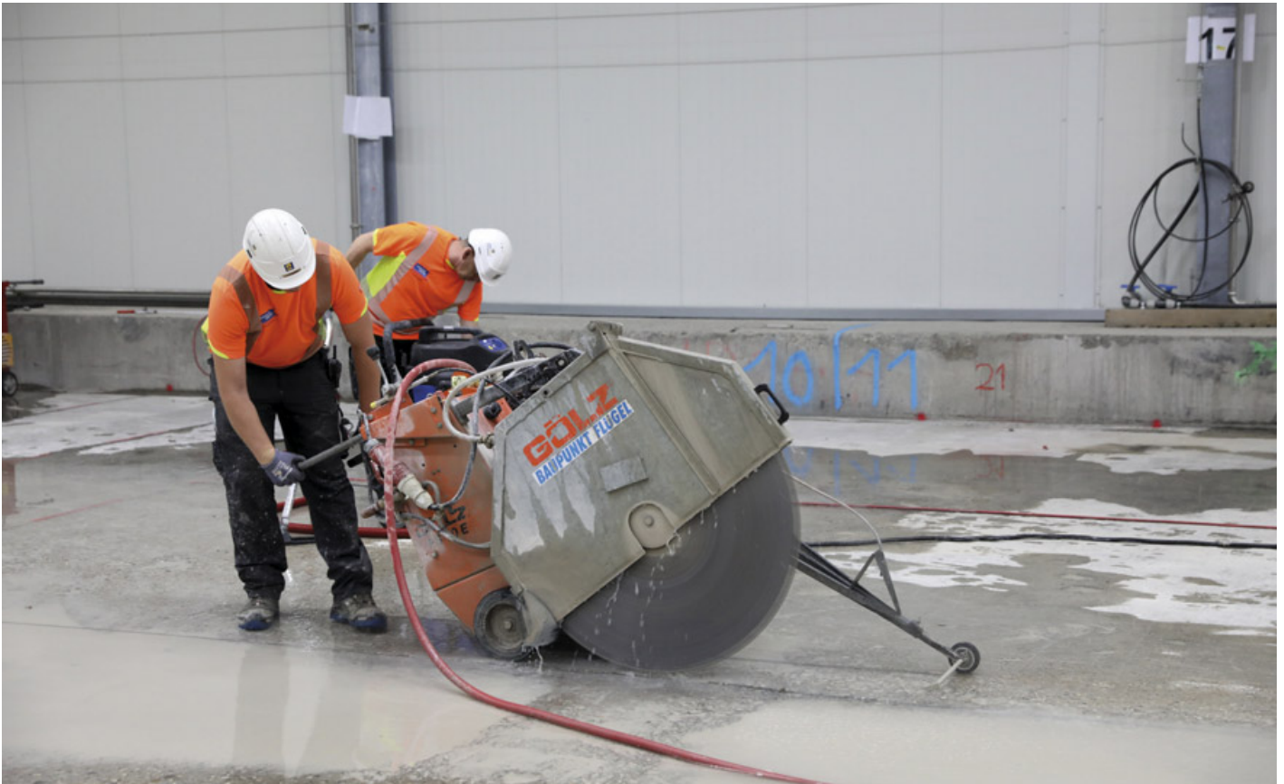
Abbildung 12: Vorbereitung des Baufelds Mitte für den Sanierungsaushub: Die Bodenplatte wird zerschnitten und abgetragen (Aufnahmedatum: 4. Juni 2020)
