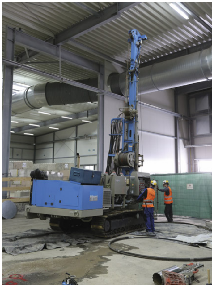
Abbildung 17: Zusatzbeprobung im Baufeld Mitte: Bohrergerät zur Bodenprobenentnahme (Aufnahmedatum: 9. November 2020)
