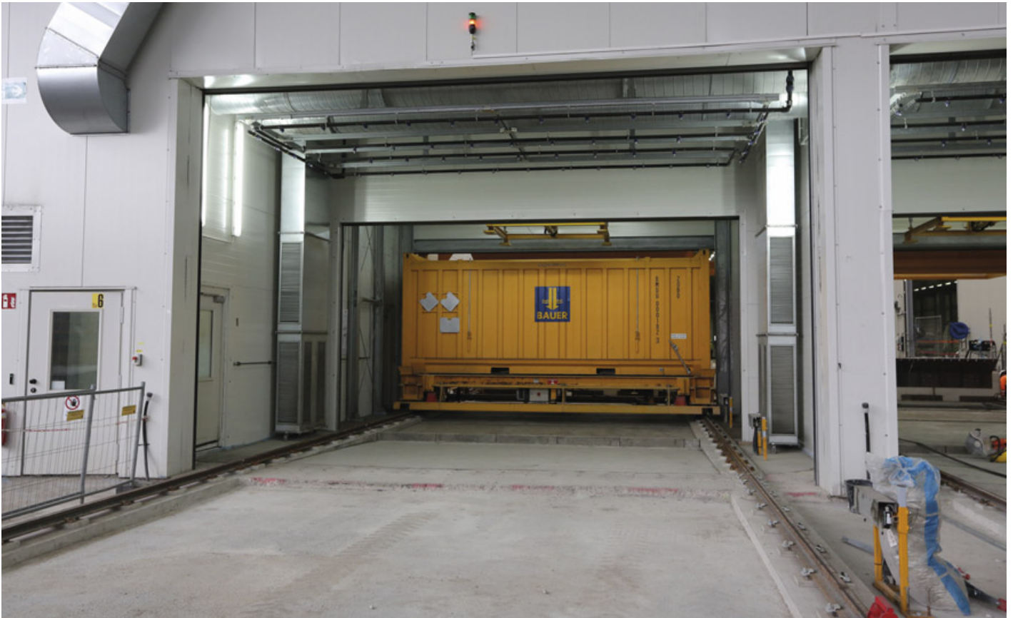
Abbildung 8: Blick in die Schleuse: Ein befüllter Transportcontainer wird ausgeschleust (Aufnahmedatum: 16. Januar 2020)
