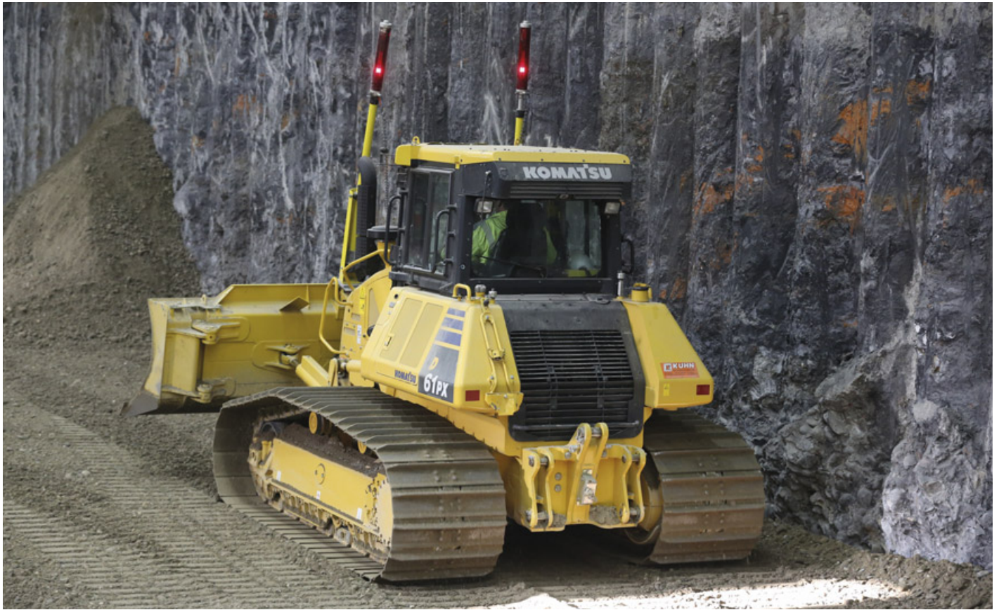
Abbildung 30: Einebnung des eingebauten Wiederverfüllmaterials (Aufnahmedatum: 24. Januar 2020)
