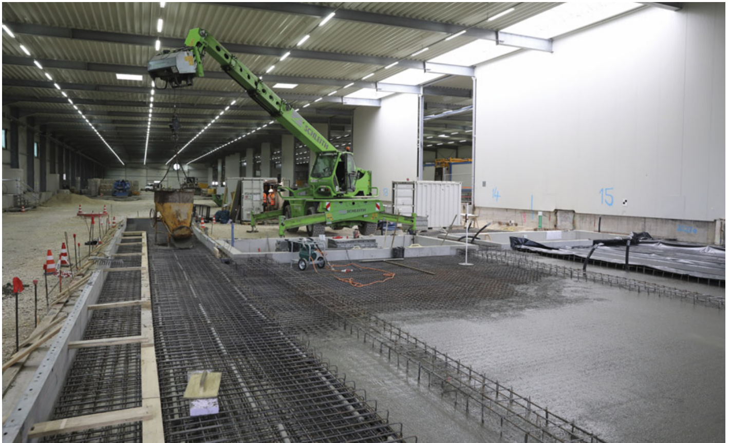
Abbildung 31: Bewehrungsarbeiten innerhalb der Sanierungshalle auf Baufeld Mitte (Aufnahmedatum: 6. Juli 2020)
