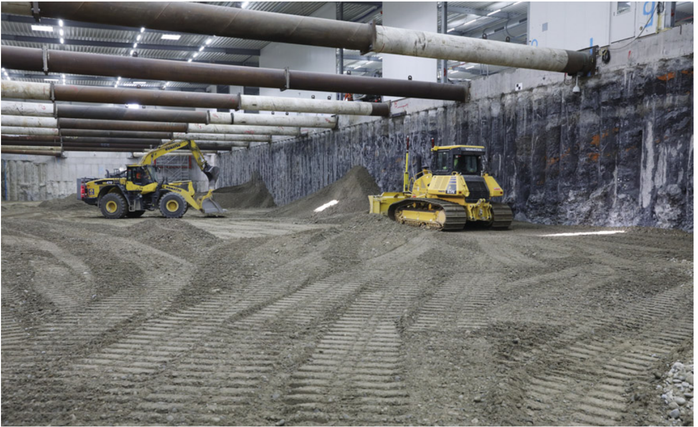
Abbildung 23: Wiederverfüllung Baufeld Süd: Das saubere Wiederverfüllmaterial wird planiert (Aufnahmedatum: 16. Januar 2020)
