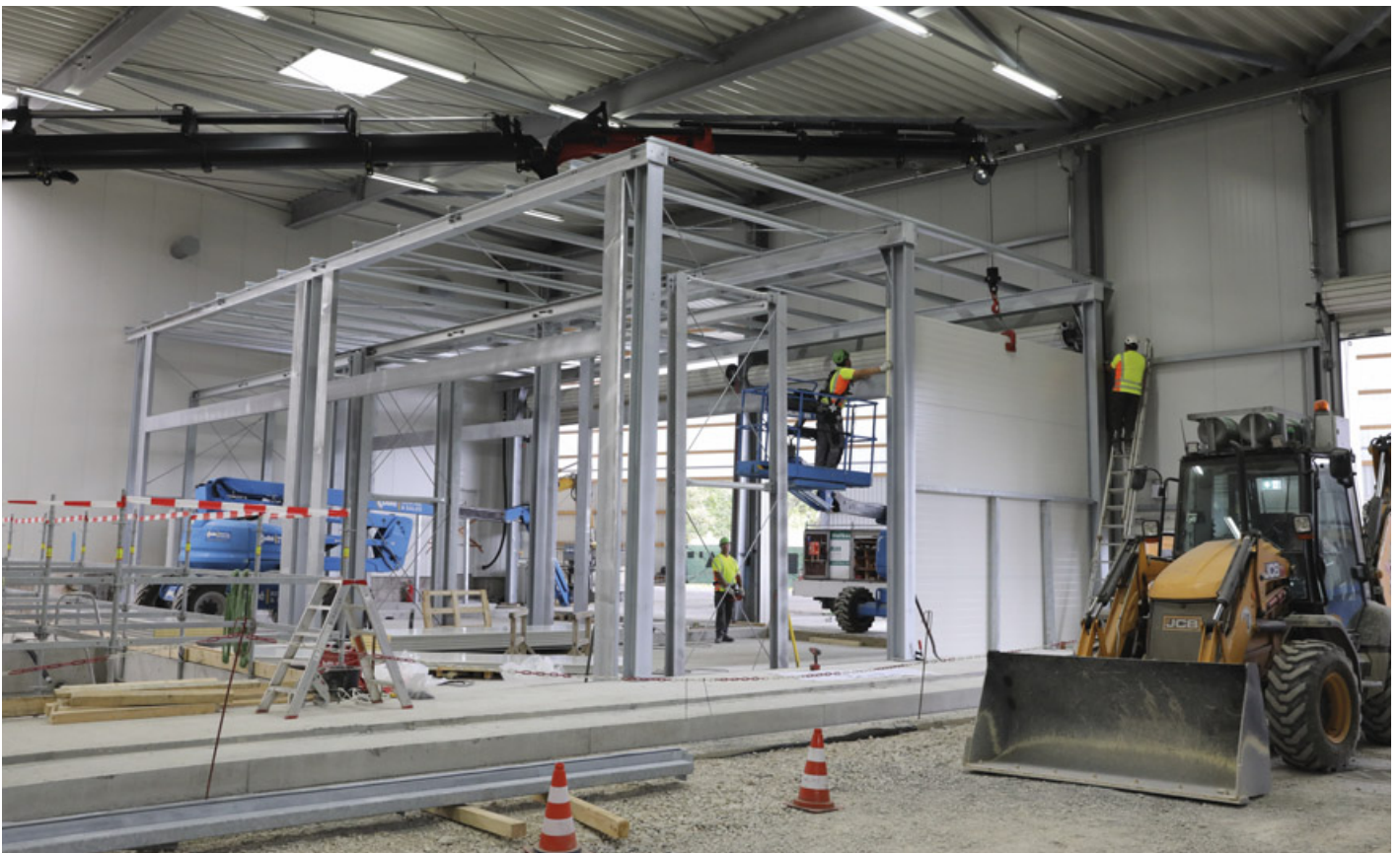
Abbildung 9: Aufbau der Containerschleuse in Baufeld Mitte (Aufnahmedatum: 16. Juli 2020)
