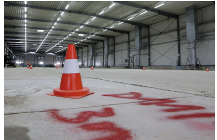
Abbildung 29: Markierung der Abteufpunkte für weitere Erkundungsbohrungen im noch zu sanierenden Bauabschnitt Mitte (Aufnahmedatum: 9. November 2020)
