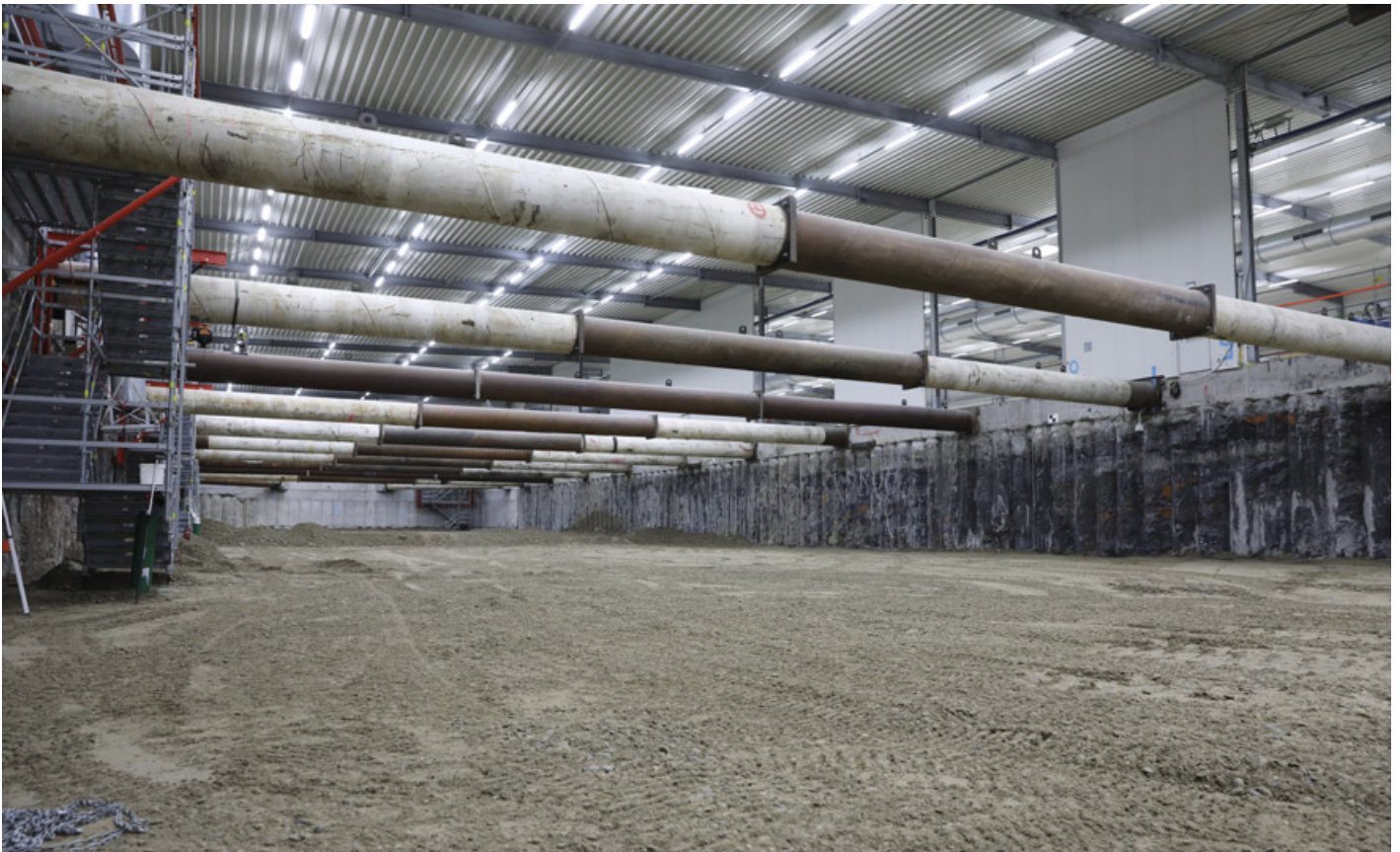
Abbildung 24: Wiederverfüllung Baufeld Süd: Die Planierarbeiten sind beendet (Aufnahmedatum: 31. Januar 2020)
