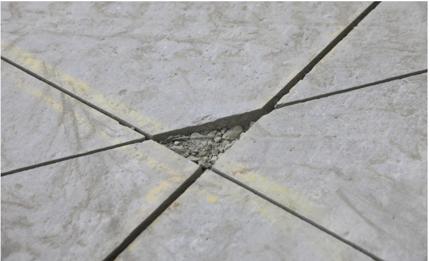
Abbildung 13: Frässchnitte im Beton (Aufnahmedatum: 4. Juni 2020)
