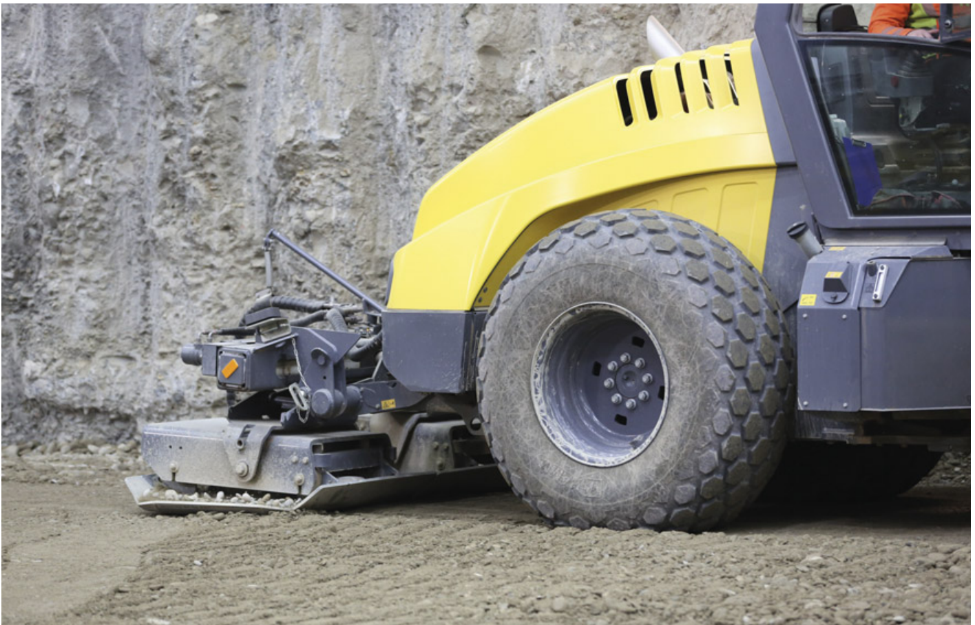
Abbildung 37: Der für die lagenweise Verdichtung des rückverfüllten Erdmaterials eingesetzte Anbauverdichter (Aufnahmedatum: 16. Januar 2020)
