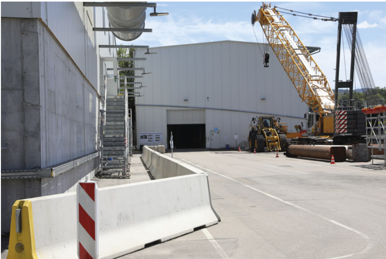
Abbildung 54: Schiffsanleger und Halle der Grundwasserreinigung (Aufnahmedatum: 9. Juli 2020)
