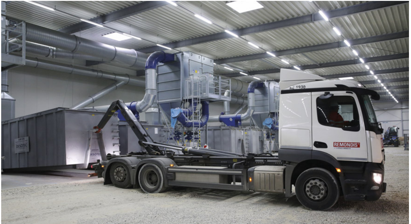
Abbildung 27: Wechsel der belasteten Aktivkohlefilter vor Beginn des letzten Bauabschnitts (Aufnahmedatum: 8. Dezember 2020)
