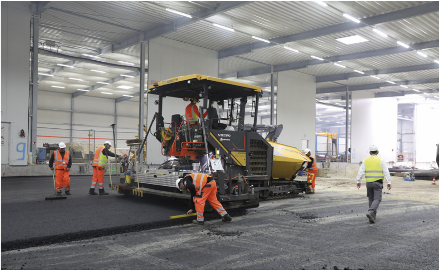
Abbildung 47: Asphaltierung des bereits sanierten Baufelds Süd (Aufnahmedatum: 11. Mai 2020)
