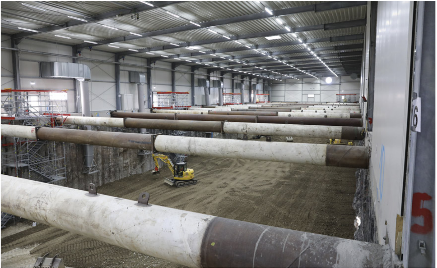
Abbildung 46: Das Sanierungsbaufeld wird zur Stabilisierung mit jeweils dreiteiligen Stahlröhren ausgesteift (Aufnahmedatum: 16. Januar 2020)
