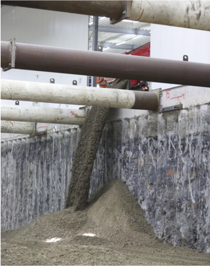
Abbildung 33: Bauabschnitt Süd: Einbringen von sauberem Verfüllmaterial (Aufnahmedatum: 24. Januar 2020)
