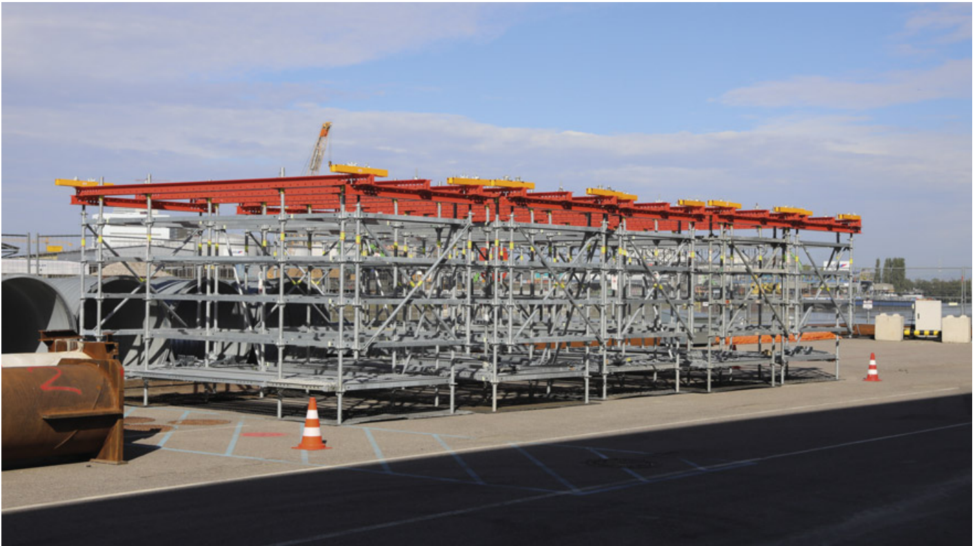
Abbildung 40: Auf dem Schiffsanleger zwischengelagerte Treppentürme (Fluchttreppen aus dem Baufeld) (Aufnahmedatum: 13. Dezember 2020)
