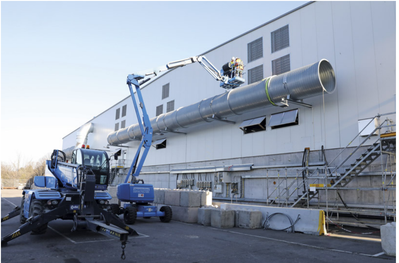
Abbildung 35: Umbau der Abluftreinigungsanlage (ALRA) für Bauabschnitt Mitte (Aufnahmedatum: 16. Januar 2020)
