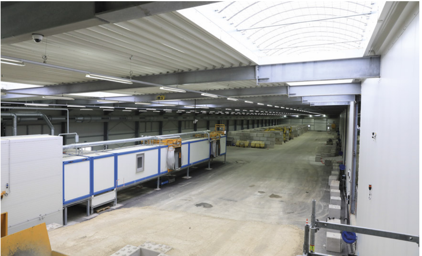
Abbildung 48: Blick in das bereits sanierte Baufeld Süd, wo zum Aushub von Baufeld Mitte der Logistikbereich aufgebaut wurde (Aufnahmedatum: 4. Februar 2020)
