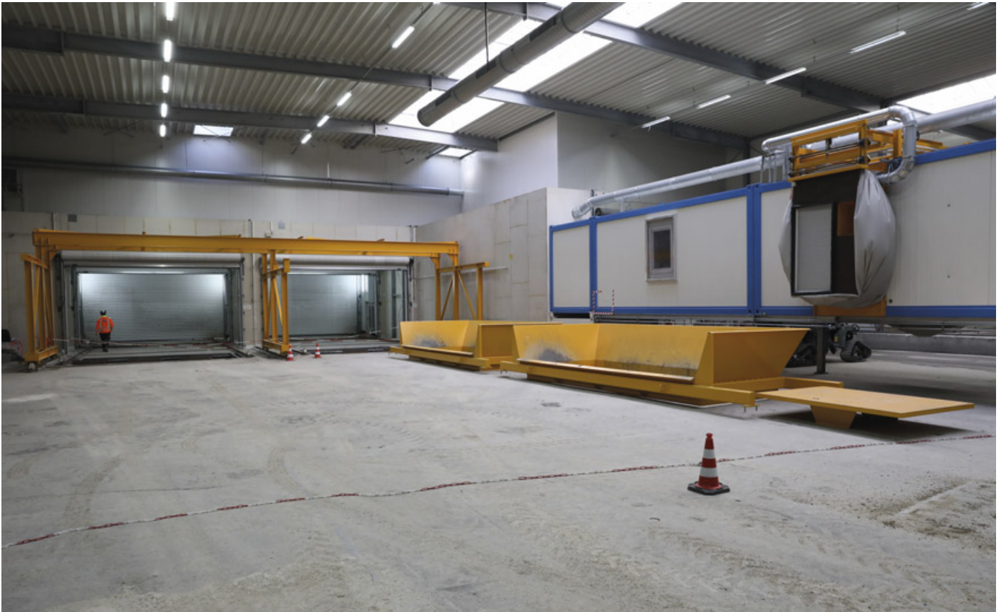
Abbildung 7: Rückbau der Schleusen in Bauabschnitt Mitte (Aufnahmedatum: 16. Januar 2020)
