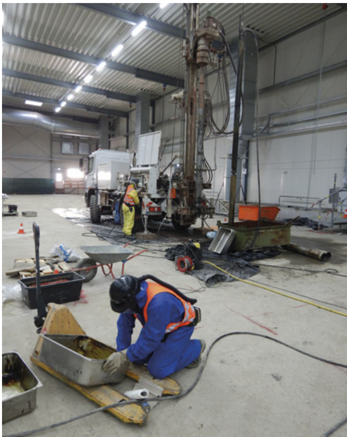
Abbildung 28: Zusatzbeprobung in Bauabschnitt Mitte (Aufnahmedatum: 11. November 2020)
