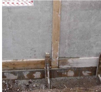
Abb. 2-7: Vornässen der Elementwand (links: Hohmann 2011a) und Verschalung der Aufsetzfuge (rechts: Hohmann 2011b)
