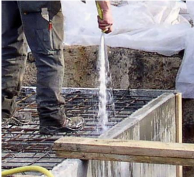
Abb. 2-7: Vornässen der Elementwand (links: Hohmann 2011a) und Verschalung der Aufsetzfuge (rechts: Hohmann 2011b)
