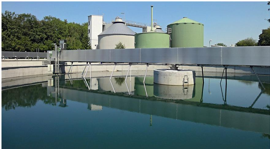
Sedimentationsbecken der Adsorptionsstufe in der Kläranlage Kressbronn
