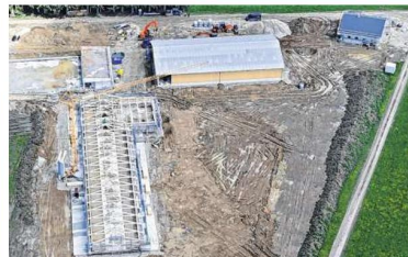
Im Sommer wollen Daniela und Franz Hörmiller ihren neuen Hof beziehen, oberhalb von Oberbeuren lassen sie den Betrieb errichten. Foto: Harald Langer
