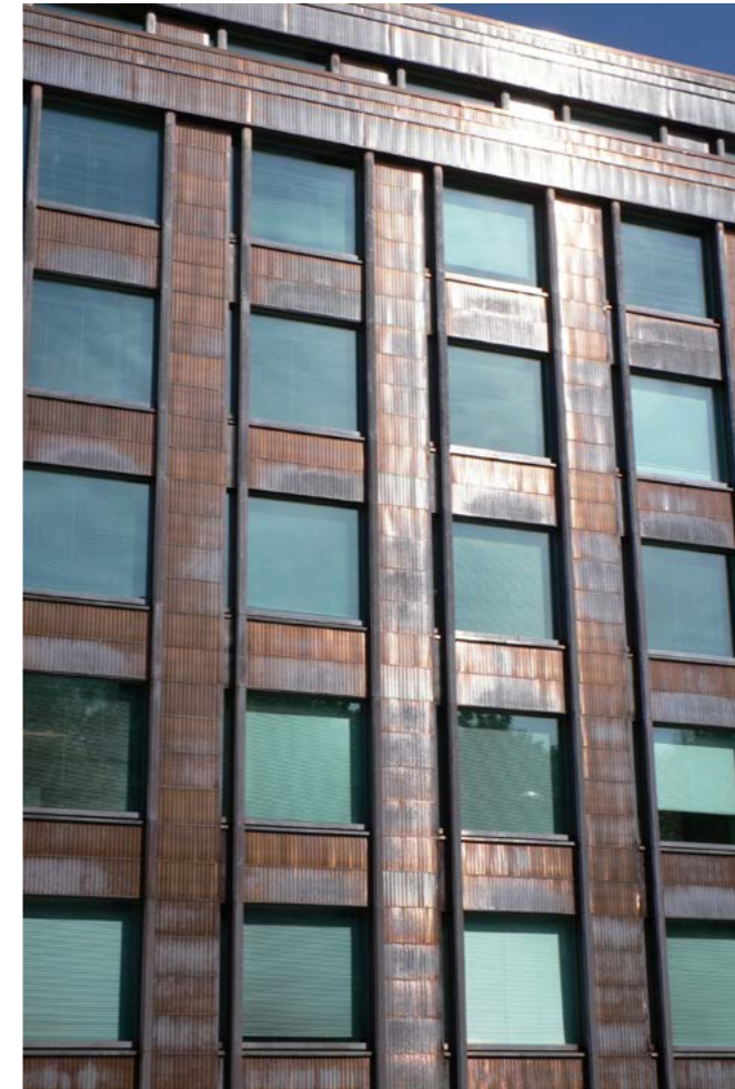
Bezirksverwaltungsgebäude, Turku, Finnland Architekt: Risto-Veikko Luukkonen und Helmer Steenroos Foto © Robert Pinter
