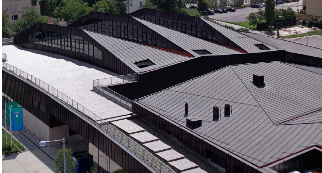
Sport- und Freizeitzentrum, Budapest, Ungarn Architekt: T2.a Architects Foto © Zsolt Batár
