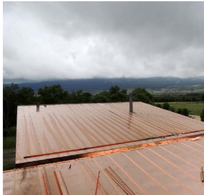
Landhaus Segovia, Spanien Architekt: Forero Arquitectura
