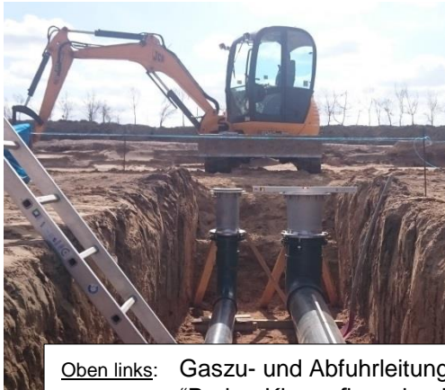
Oben rechts: Boden-Klemmflansche (mit Abstandshalter) V4A in Bodenmembrane
