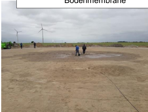
Streifen-Ringfundament, Oberfläche eben und "leicht geglättet (Glättkellenstrich)"
